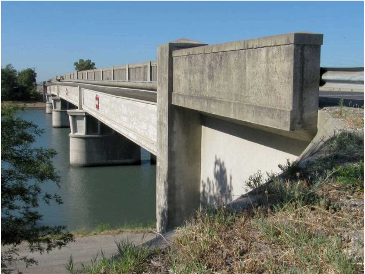
Vue générale, face aval, de côté (depuis la rive gauche)
