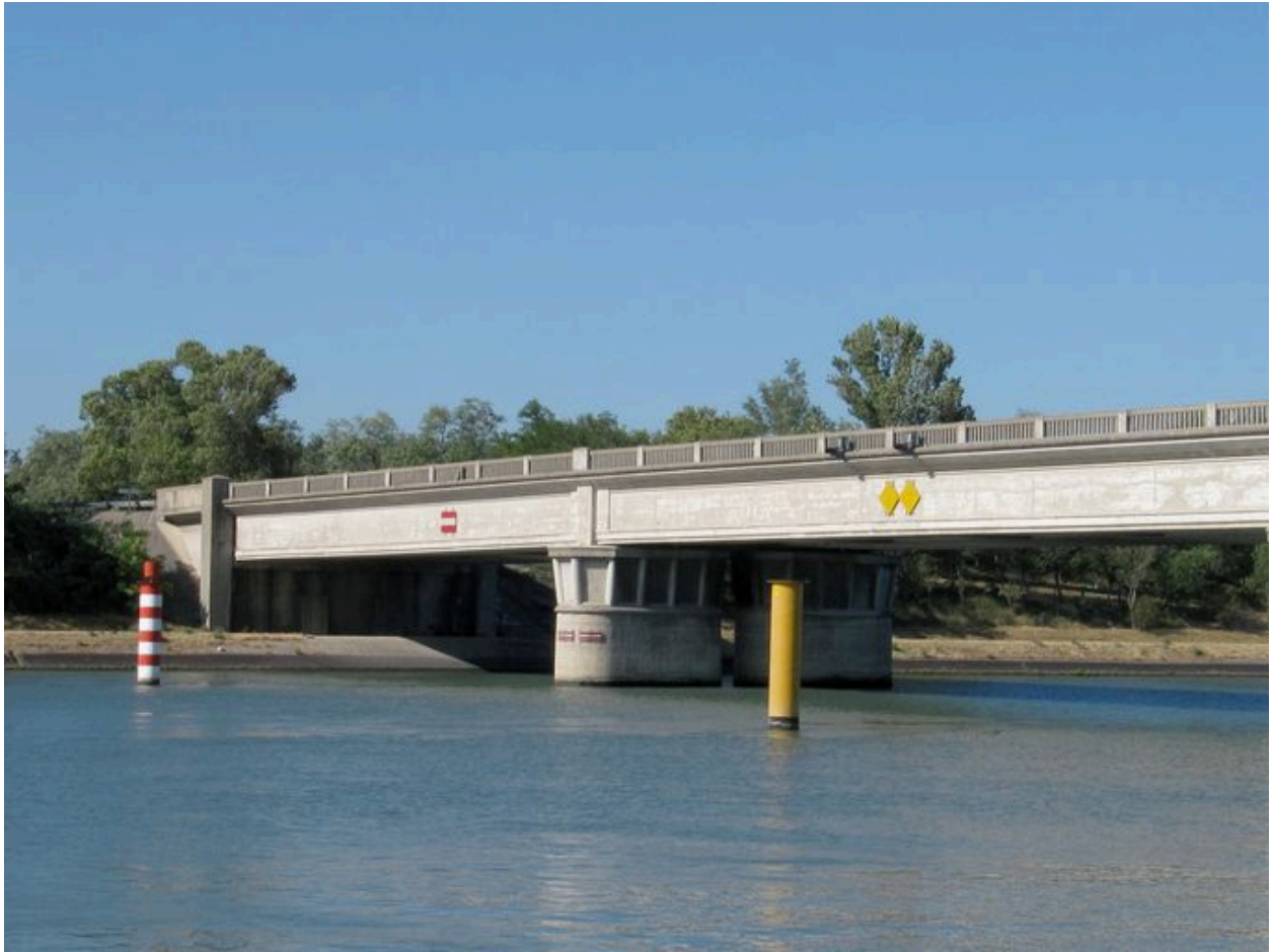
Vue partielle, culée et travée droite, face aval (depuis la rive gauche)
