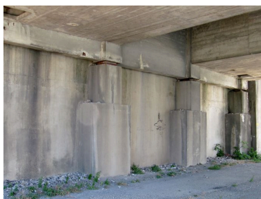
Culée droite, vue partielle : jonction avec le tablier (depuis la rive droite) Phot. I. Havard IVR82_20102600192NUCA
