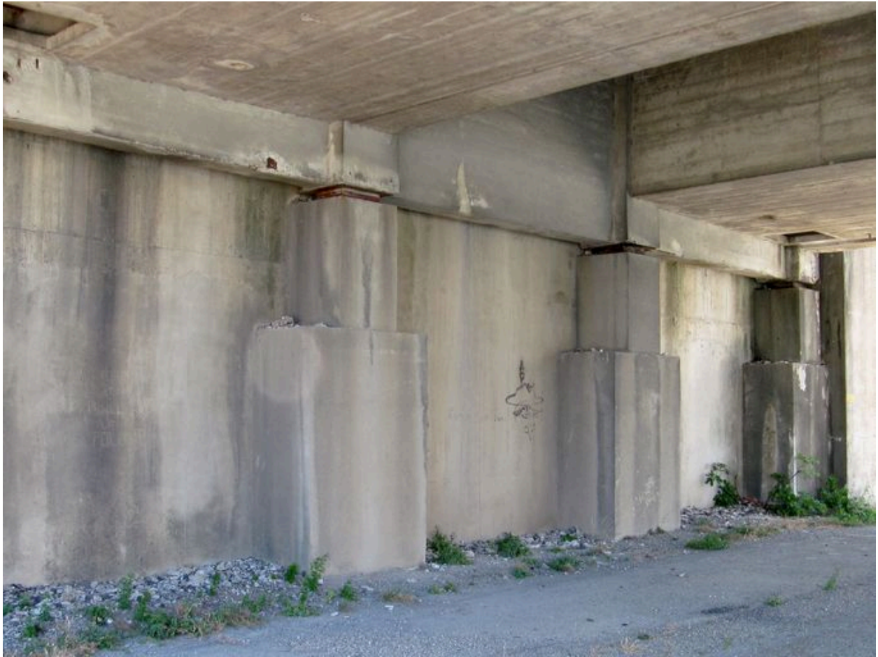
Culée droite, vue partielle : jonction avec le tablier (depuis la rive droite)
