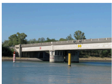
Vue partielle, culée et travée droite, face aval (depuis la rive gauche) Phot. I. Havard IVR82_20102600188NUCA
