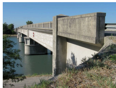
Vue générale, face aval, de côté (depuis la rive gauche) Phot. I. Havard IVR82_20102600186NUCA
