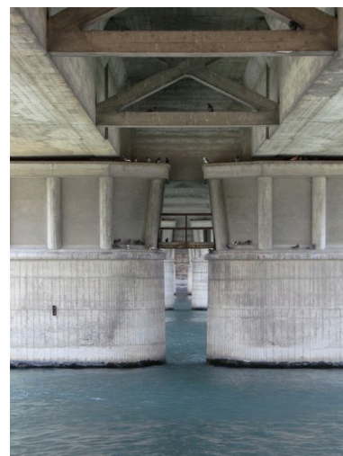
Vue partielle, de dessous, tablier et piles (depuis la rive droite)
