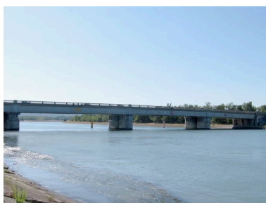
Vue partielle, face amont (depuis la rive gauche) Phot. I. Havard IVR82_20102600185NUCA
