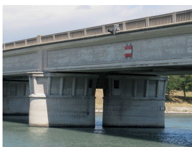
Pile, face amont, vue générale (depuis la rive droite) Phot. I. Havard IVR82_20102600189NUCA
