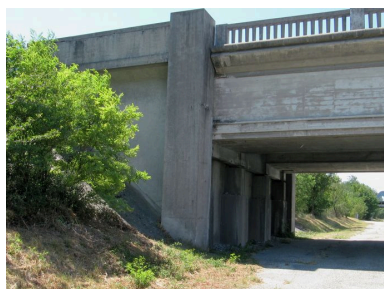
Culée droite, face aval, vue générale (depuis la rive droite) Phot. I. Havard IVR82_20102600191NUCA
