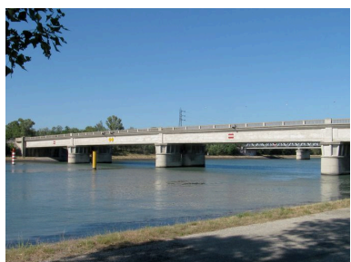
Vue partielle, face aval (depuis la rive gauche) Phot. I. Havard IVR82_20102600184NUCA
