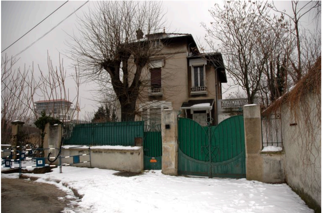
Vue générale depuis le sud-ouest
