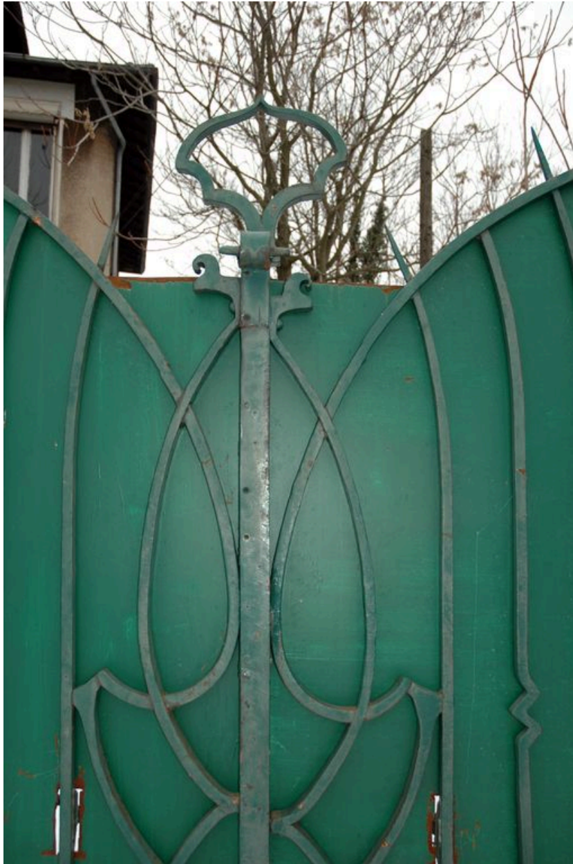
Détail de la grille d'entrée du jardin
