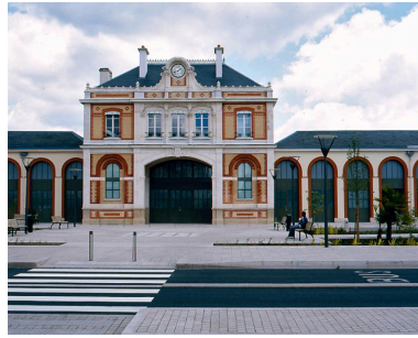
Le pavillon central et l'entrée des voyageurs depuis la place de la Gare. Phot. Christian Parisey IVR83_20090300547XA
