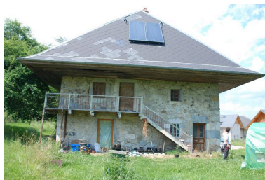
Vue d'ensemble. Phot. Thierry Monnet IVR84_20207400239NUCA
