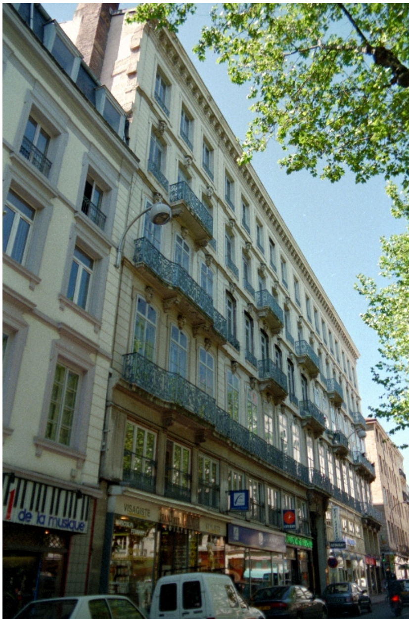
Façade principale. Etat en 1997
