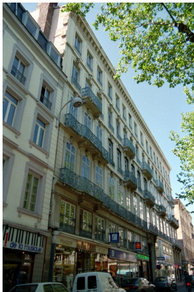
Façade principale. Etat en 1997 Phot. Cendrine Sanquer IVR82_19974201842ZE
