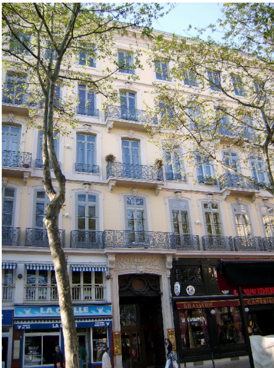
Vue de la travée centrale
