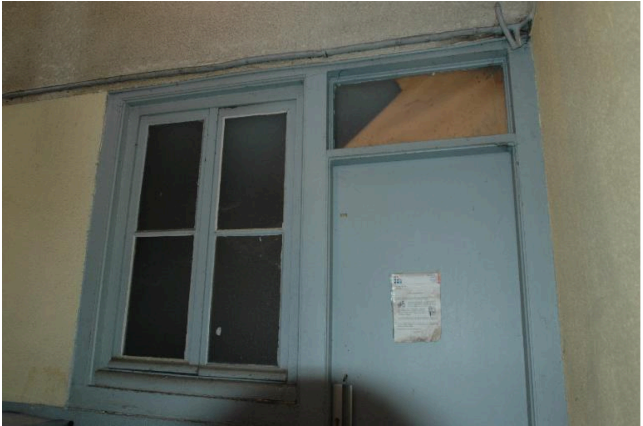
Détail du bâtiment situé dans la cour
