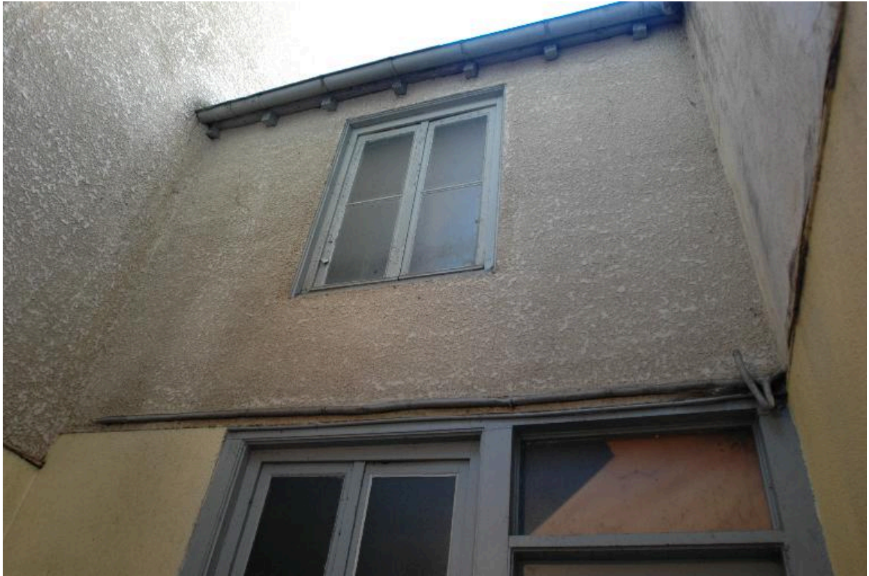
Détail du bâtiment situé dans la cour
