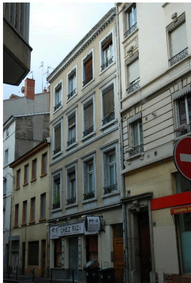
Vue générale Phot. Catherine Guillot IVR82_20136900112NUCA
