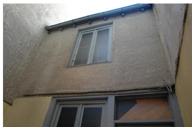
Détail du bâtiment situé dans la cour Phot. Catherine Guillot IVR82_20136900063NUCA
