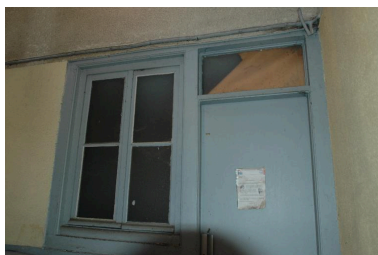
Détail du bâtiment situé dans la cour Phot. Catherine Guillot IVR82_20136900064NUCA
