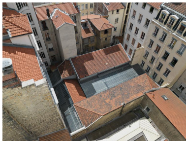
Vue générale des élévations postérieures (à gauche) Phot. Eric Dessert IVR82_20126901700NUCA
