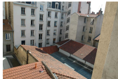
Vue partielle des élévations sur cour (à droite) Phot. Catherine Guillot IVR82_20136900087NUCA
