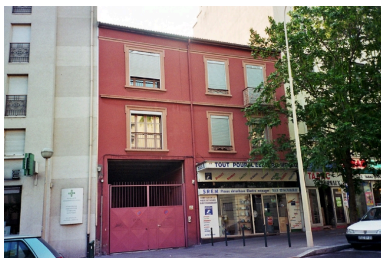
Vue générale ouest Phot. Nadine Halitim-Dubois IVR82_20046902956NUCA
