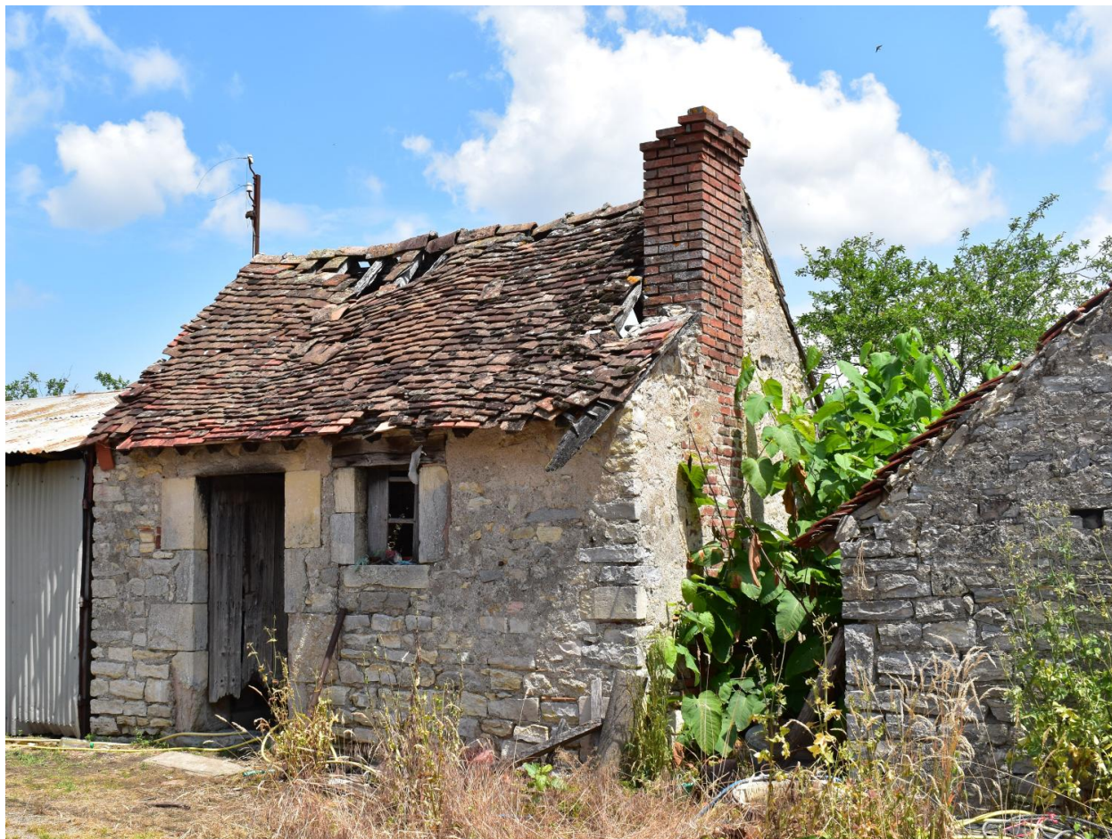
Vue générale de la pièce à cheminée.
