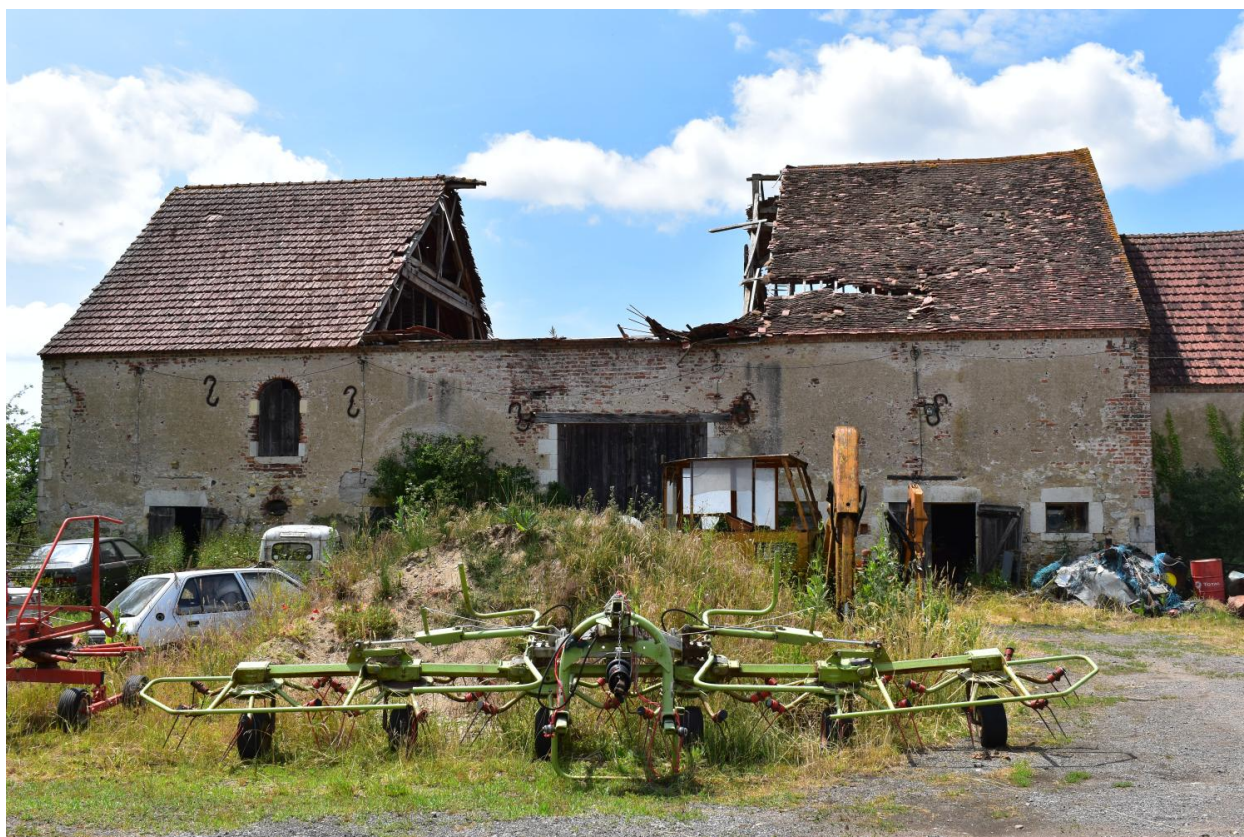
Vue générale de la grange.
