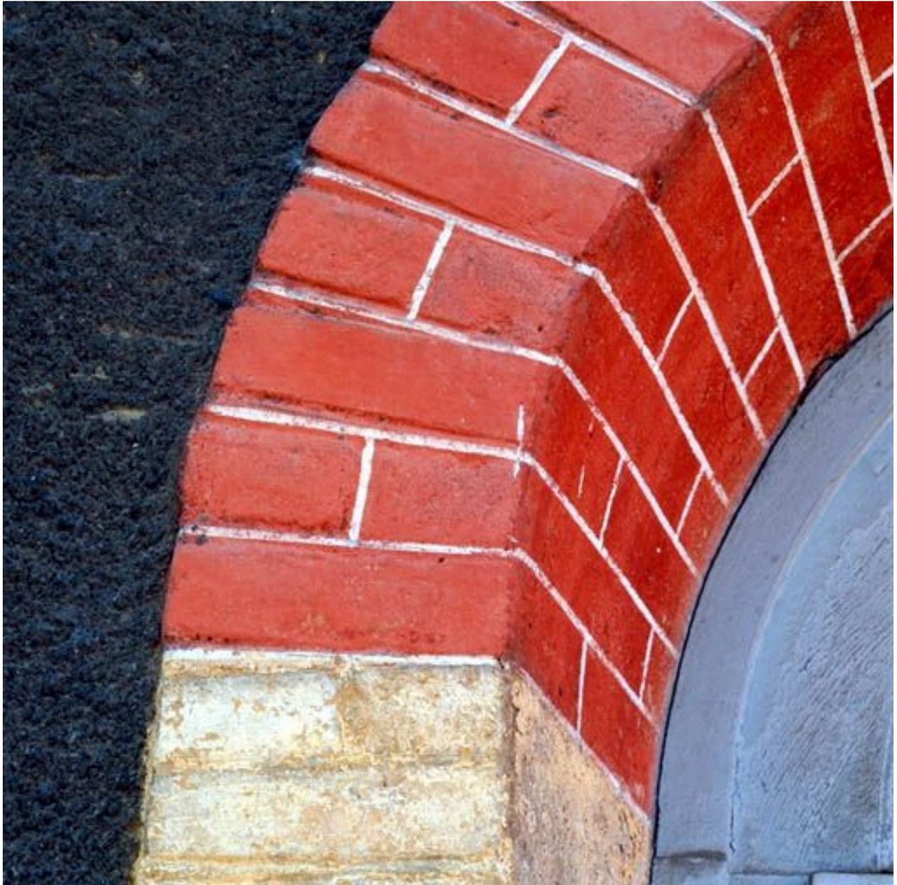
Les communs, détail d'un arc : un faux appareil peint et imitant la brique recouvre un véritable appareil de brique
