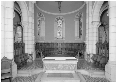
Vue d'ensemble. Phot. Eric Dessert, Phot. Jean-Marie Refflé IVR82_19910100773P
