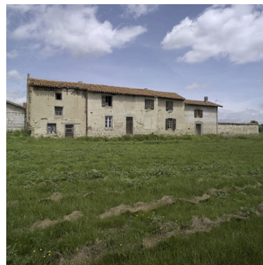
Vue d'ensemble de l'élévation sud du logis. Phot. Eric Dessert IVR82_20084201212NUCA
