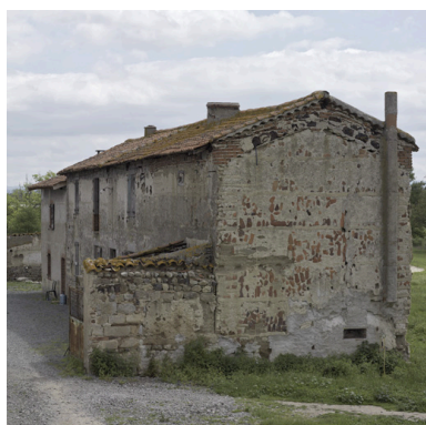
Vue du logis depuis le nord-ouest. Phot. Eric Dessert IVR82_20084201209NUCA
