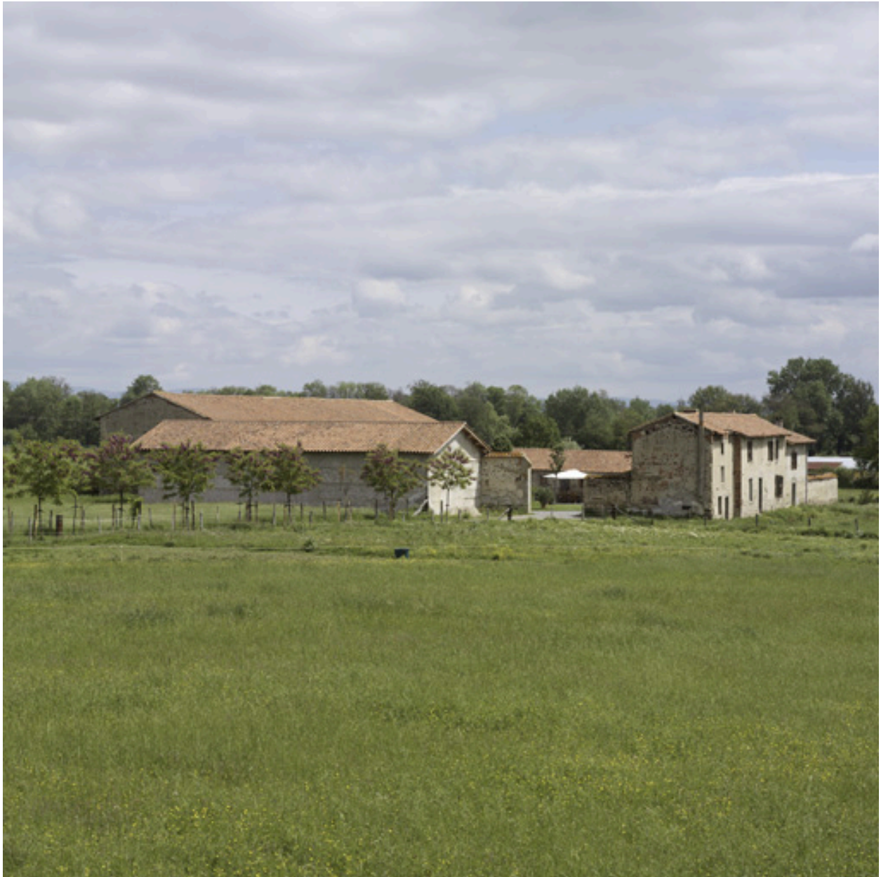
Vue générale depuis le sud-ouest.
