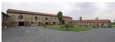
Vue d'ensemble de l'angle nord-est de la cour. Phot. Didier Gourbin IVR82_20074201172NUCAQ
