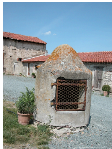
Vue du puits. Phot. Thierry Monnet IVR82_20134204340NUCA
