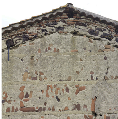
Détail du pignon ouest du logis (utilisation de ratés de cuisson dans la maçonnerie). Phot. Eric Dessert IVR82_20084201214NUCA
