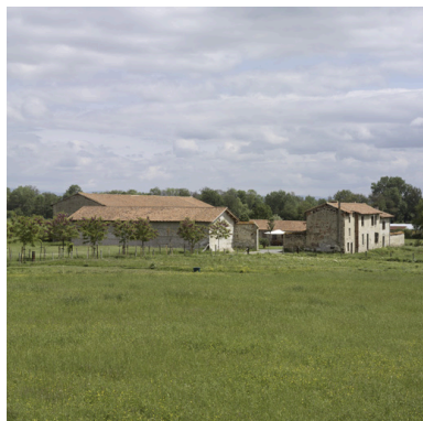
Vue générale depuis le sud-ouest. Phot. Eric Dessert IVR82_20084201236NUCA
