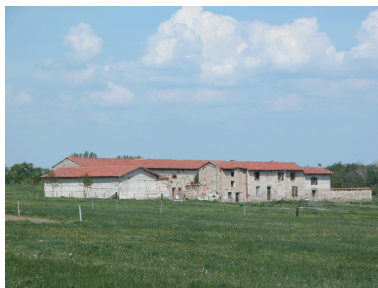
Vue générale depuis le sud-ouest. Phot. Thierry Monnet IVR82_20134204337NUCA
