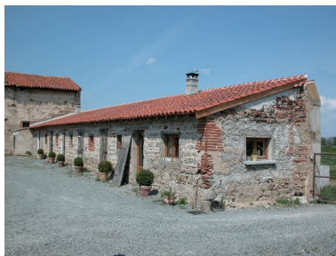
Vue des porcherie. Phot. Thierry Monnet IVR82_20134204339NUCA
