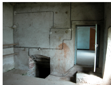
Vue intérieure du logis : accès à la cave. Phot. Thierry Monnet IVR82_20134204344NUCA
