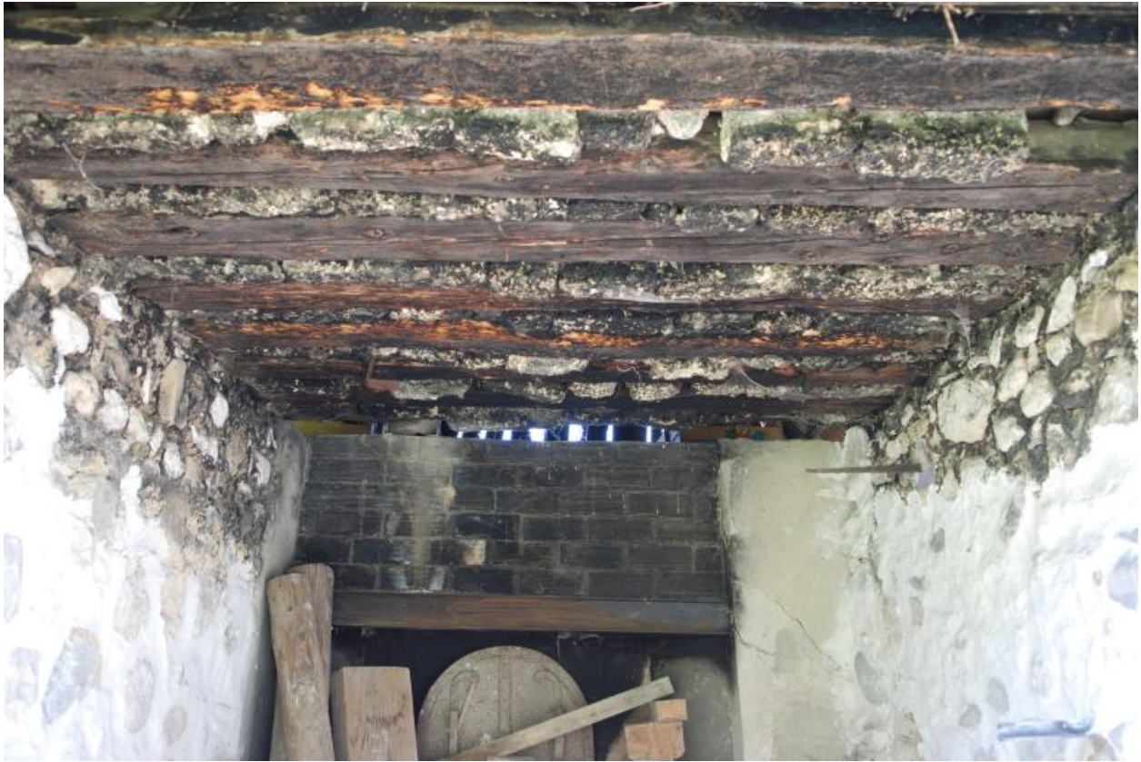
Vue d'ensemble intérieur de l'édicule : plafond an bois avec pierres entre les poutres.
