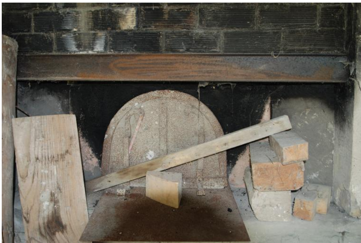
Détail de la bouche du four
