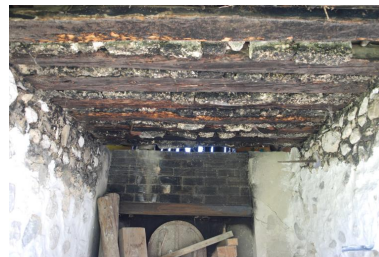
Vue d'ensemble intérieur de l'édicule : plafond en bois avec pierres entre les poutres. Phot. Thierry Monnet IVR84_20197400180NUCA
