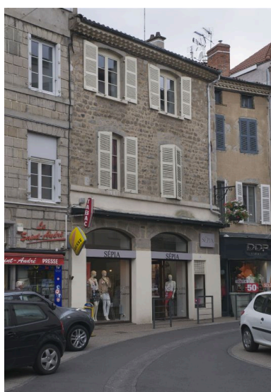
Elévation principale depuis la place Saint-André. Phot. Thierry Leroy IVR82_20134202613NUCAQ
