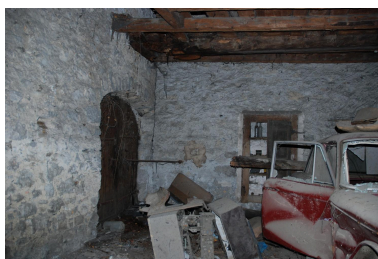
Vue intérieure, rez- de-chaussée : remise. Phot. Caroline Guibaud IVR84_20253801135NUCA
