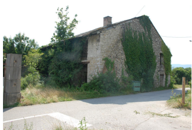
Vue d'ensemble depuis le nord-est. Phot. Caroline Guibaud IVR84_20253801131NUCA
