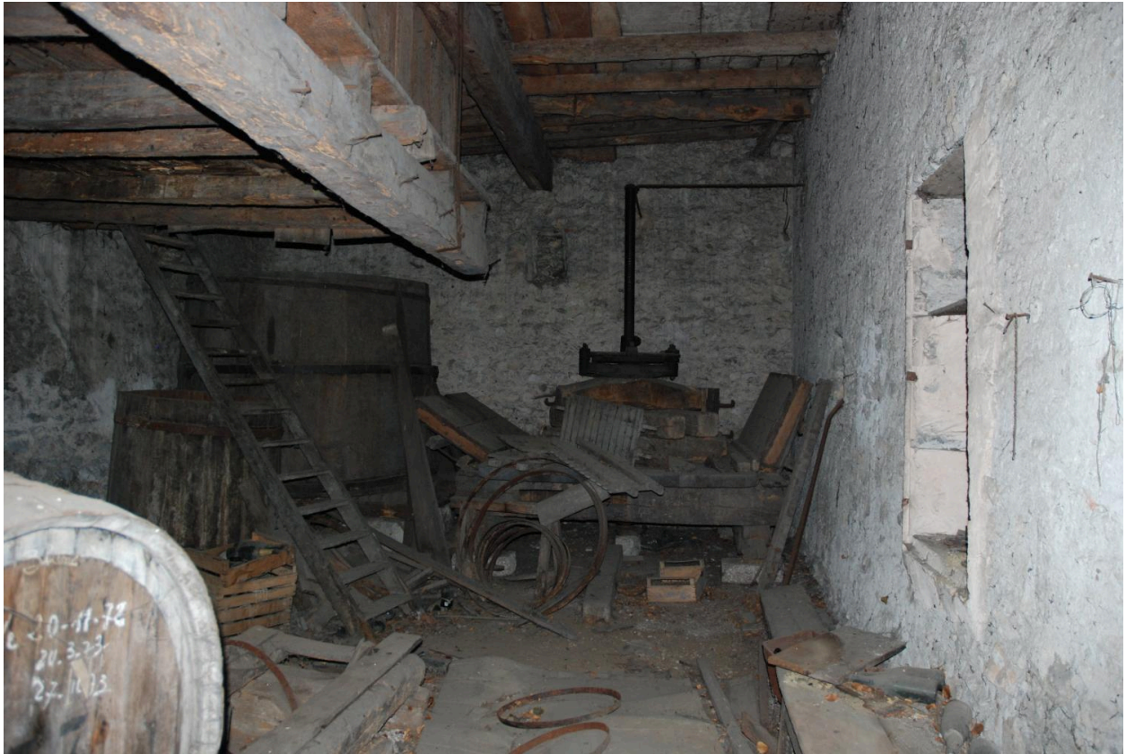
Vue intérieure, rez-de-chaussée : cuvage.
