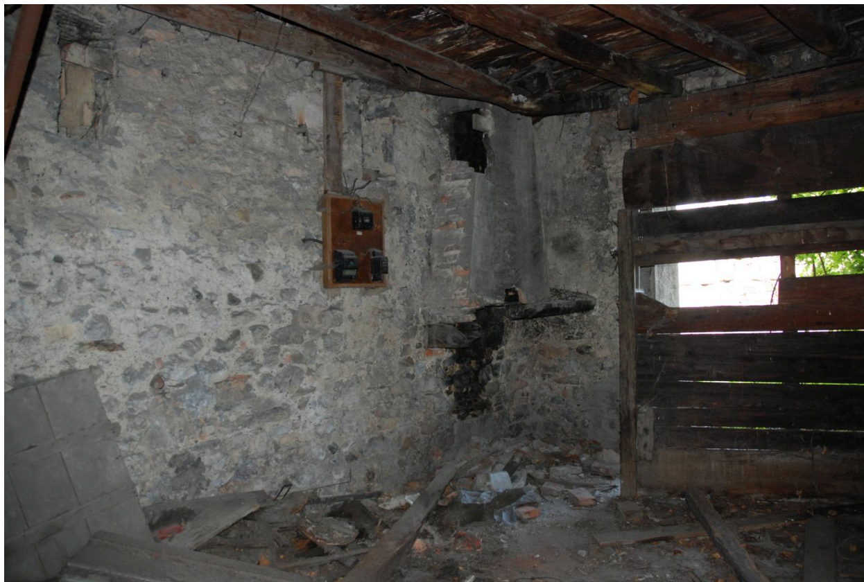
Vue intérieure, rez-de-chaussée : remise.
