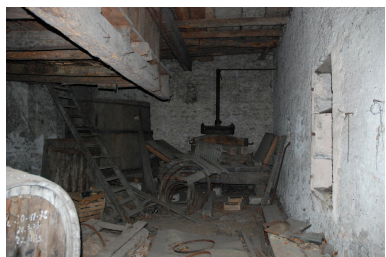
Vue intérieure, rez- de-chaussée : cuvage. Phot. Caroline Guibaud IVR84_20253801132NUCA
