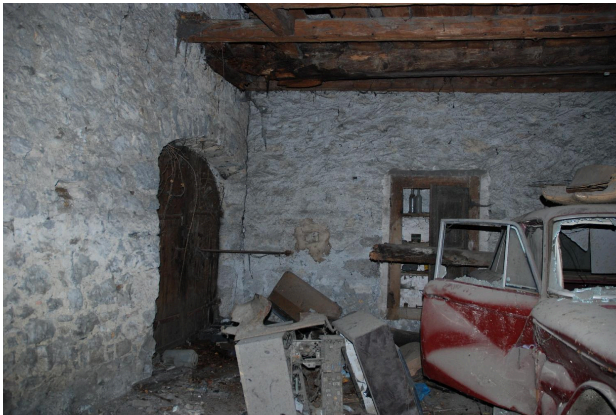
Vue intérieure, rez-de-chaussée : remise.
