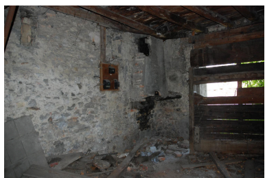
Vue intérieure, rez- de-chaussée : remise. Phot. Caroline Guibaud IVR84_20253801136NUCA
