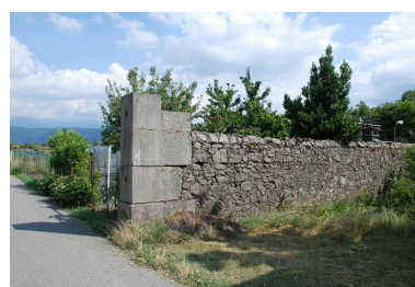
Mur du clos avec pilier en pierre de taille. Phot. Caroline Guibaud IVR84_20253801138NUCA
