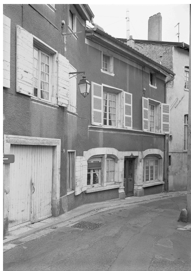
Elévation sur rue. Phot. Jean-Marie Refflé IVR82_19900100290P
