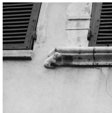
Elévation sur jardin, appui de fenêtre, détail culot gauche : chien. Phot. Jean-Marie Refflé IVR82_19900100476X
