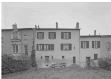
Elévation sur jardin (à droite, maison n°29 rue du Gouvernement, à gauche, maison basse des Sires de Villars, séparée par une venelle latrinale). Phot. Jean-Marie Refflé IVR82_19900100423P
