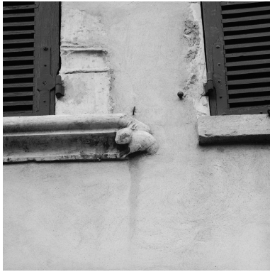
Elévation sur jardin, appui de fenêtre, détail culot droit : lapin.
