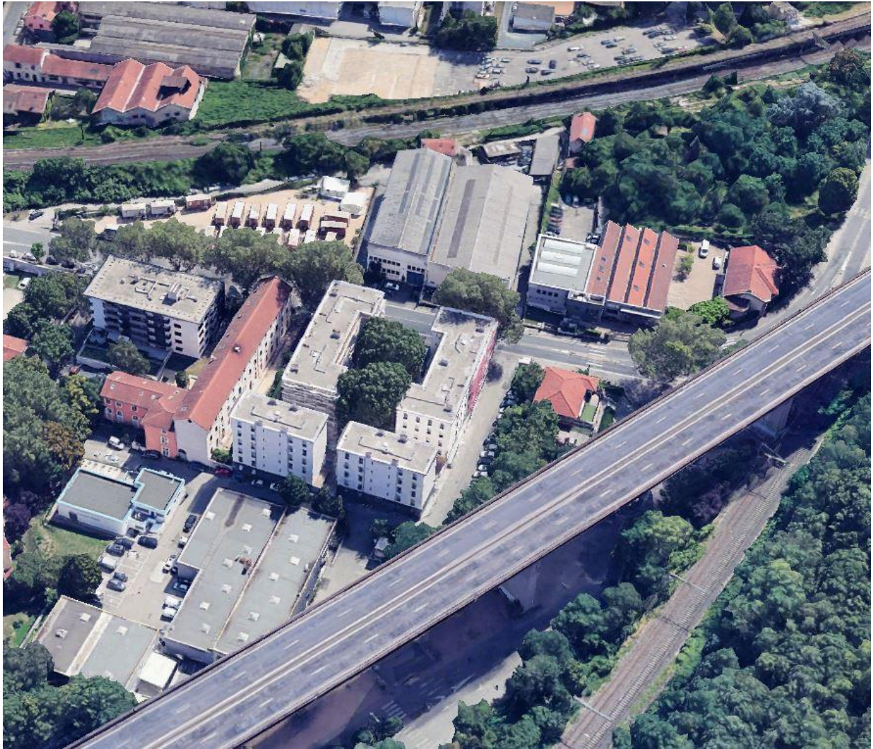
Vue d'ensemble des ateliers à Vaise Sidoine Apollinaire (vue Google)
