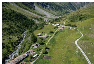
Hameau d'Avérole partie aval Phot. Michel Pérès IVR84_20227301183NUCA
