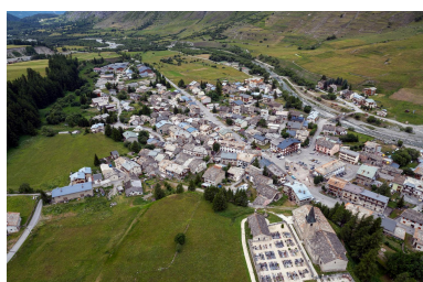
vue d'ensemble, Centre et partie aval de la commune de Bessans (drone) Phot. Michel Pérès IVR84_20227301172NUCA
