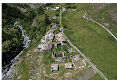
Hameau d'Avérole, vue de l'amont, bourg d'amont au premier plan Phot. Michel Pérès IVR84_20227301182NUCA
