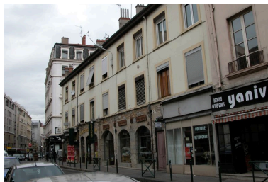
Vue générale de la façade sur rue Phot. N. Giroud IVR82_20046904132NUCA
