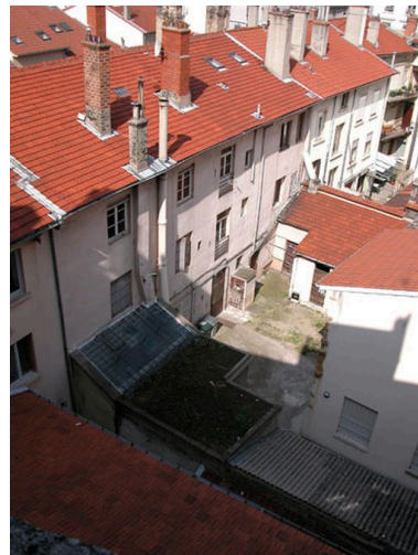
Elévation postérieure depuis un immeuble avenue Jean-Jaurès au nord-est Phot. Maryannick Chalabi IVR82_20046904506NUCA
