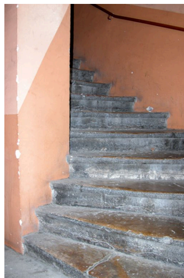
Départ de l'escalier Phot. N. Giroud IVR82_20046904133NUCA
