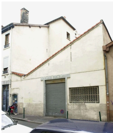
Vue de la façade sur rue Phot. François Blanchetière IVR82_20016901574NUCA
