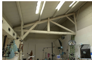
Vue de la charpente de l'entrepôt Phot. François Blanchetière IVR82_20016901577NUCA
