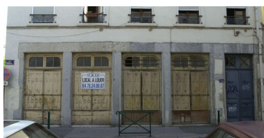
Vue de la devanture de l'immeuble voisin Phot. François Blanchetière IVR82_20016901576NUCA
