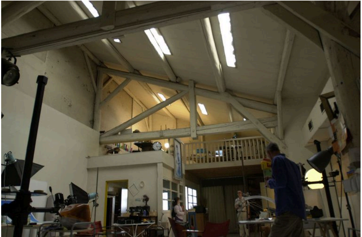
Vue de la charpente de l'entrepôt
