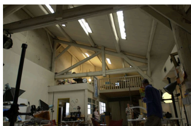
Vue de la charpente de l'entrepôt Phot. François Blanchetière IVR82_20016901578NUCA
