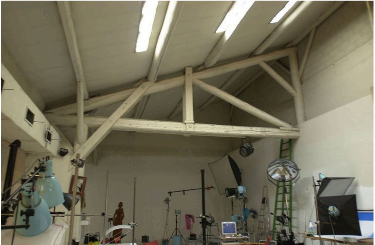
Vue de la charpente de l'entrepôt
