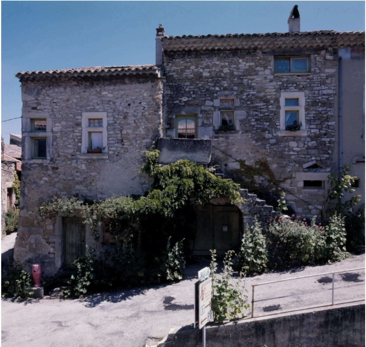
Vue générale de l'élévation principale.
