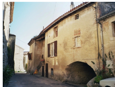
Vue d'ensemble de la façade sur la Grand rue. Phot. Geneviève Jourdan IVR82_20072600103NUCA
