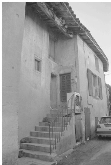
Elévation sur rue. Phot. Geneviève Jourdan IVR82_20042600011Z
