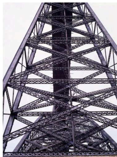
Détail de la structure métallique de l'une des piles du viaduc, vue en contre-plongée. Phot. Roger Choplain, Phot. Roland Maston IVR83_19921500240XA
