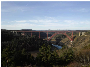
Vue générale du site du viaduc de Garabit. Phot. Jean-Michel Périn IVR83_20151500058NUC4A
