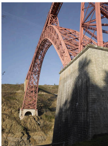
Structure du viaduc vue en contre-plongée, depuis l'une des piles.. Phot. Jean-Michel Périn IVR83_20151500060NUC4A
