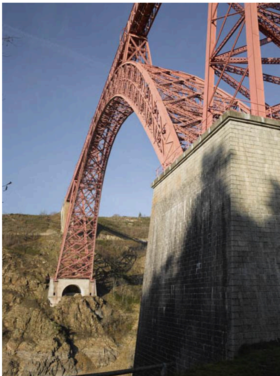
Structure du viaduc vue en contre-plongée, depuis l'une des piles..
