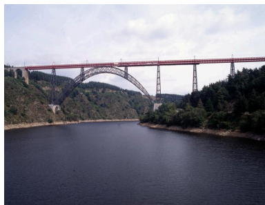
Vue de trois quarts du viaduc depuis les rives de la Truyère. Phot. Roger Choplain, Phot. Roland Maston IVR83_19921500242XA
