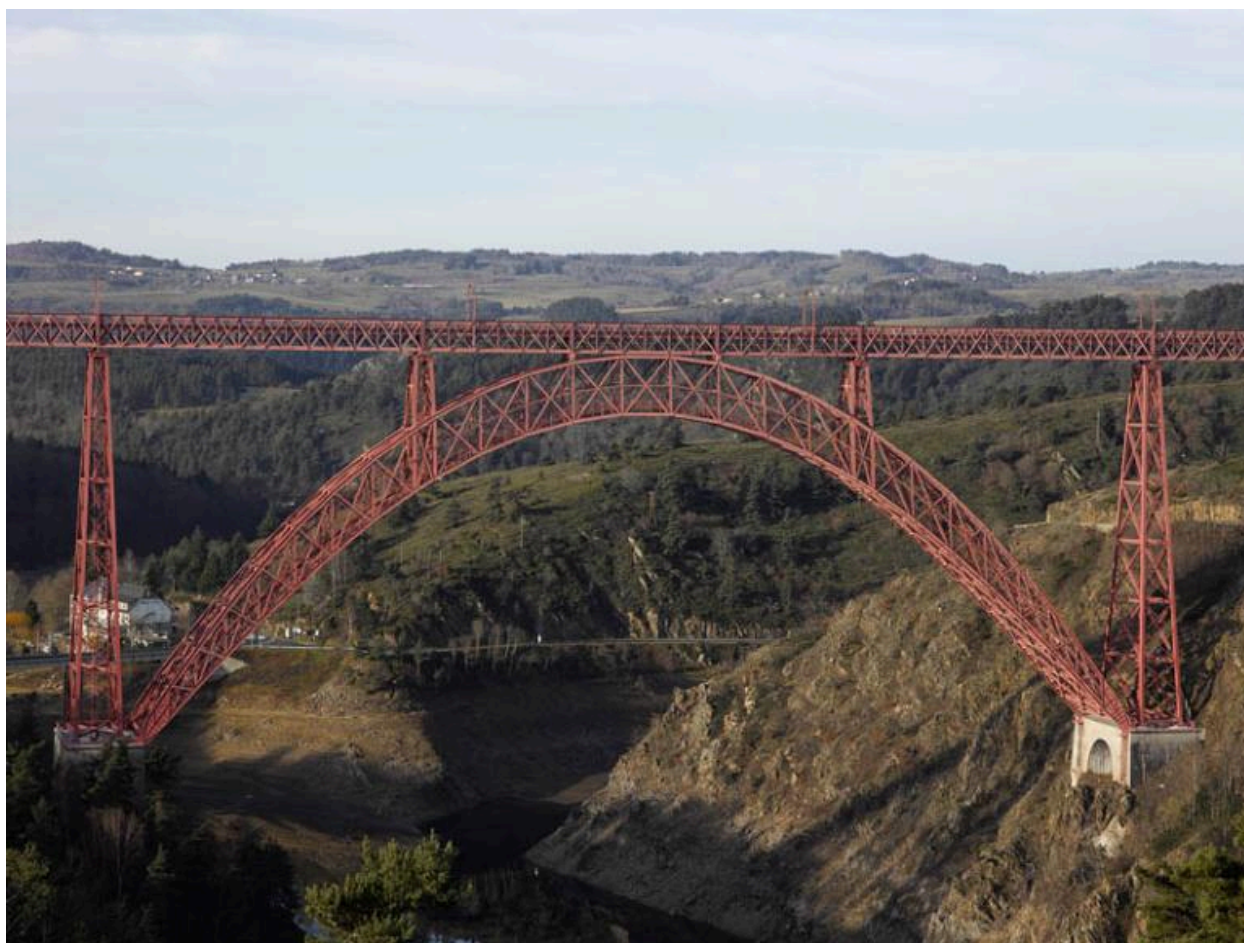
Vue sur la partie centrale du viaduc.
