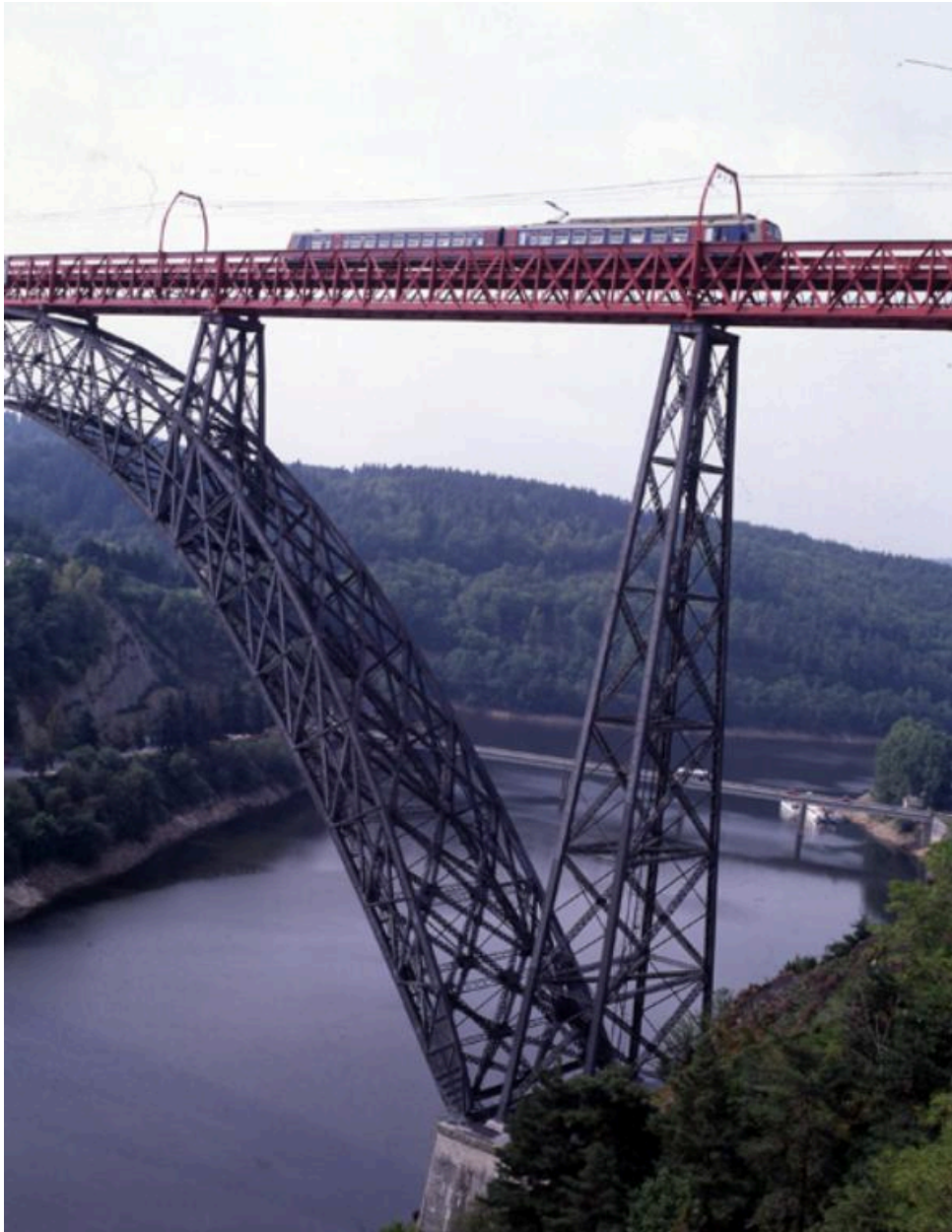
Vue partielle du viaduc au moment du passage d'un train.
