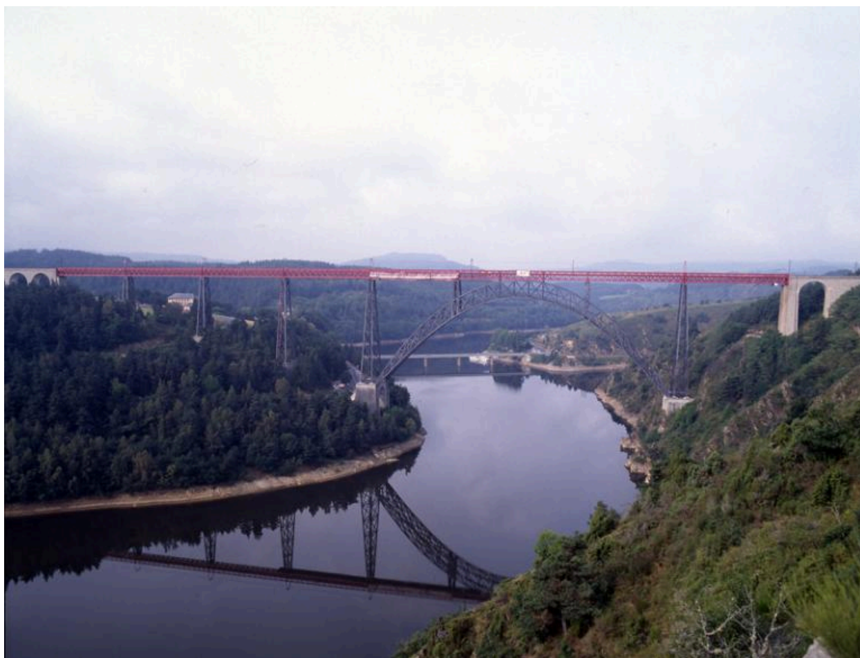
Vue générale du viaduc dans le site.
