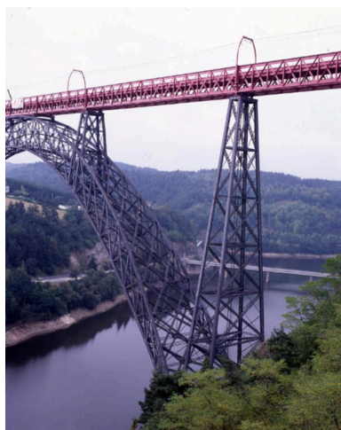
Détail de l'une des piles métalliques et du départ de l'arche centrale du viaduc. Phot. Roger Choplain, Phot. Roland Maston IVR83_19921500262XA
