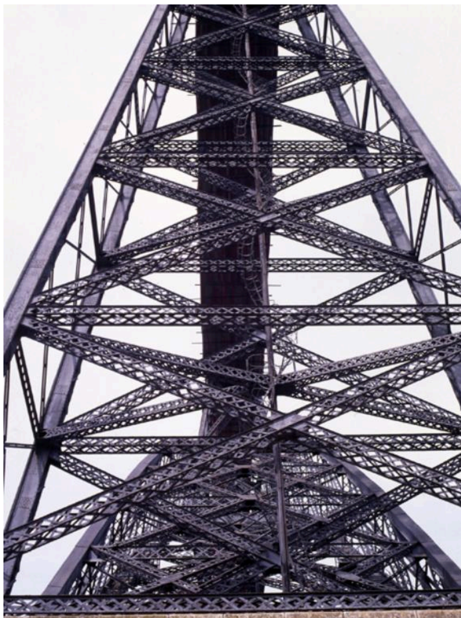
Détail de la structure métallique de l'une des piles du viaduc, vue en contre-plongée.
