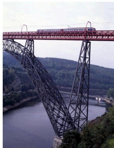
Vue partielle du viaduc au moment du passage d'un train. Phot. Roger Choplain, Phot. Roland Maston IVR83_19921500263XA
