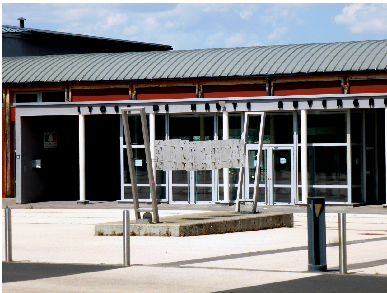
Installation n°1, nouvelle version : vue d'ensemble
