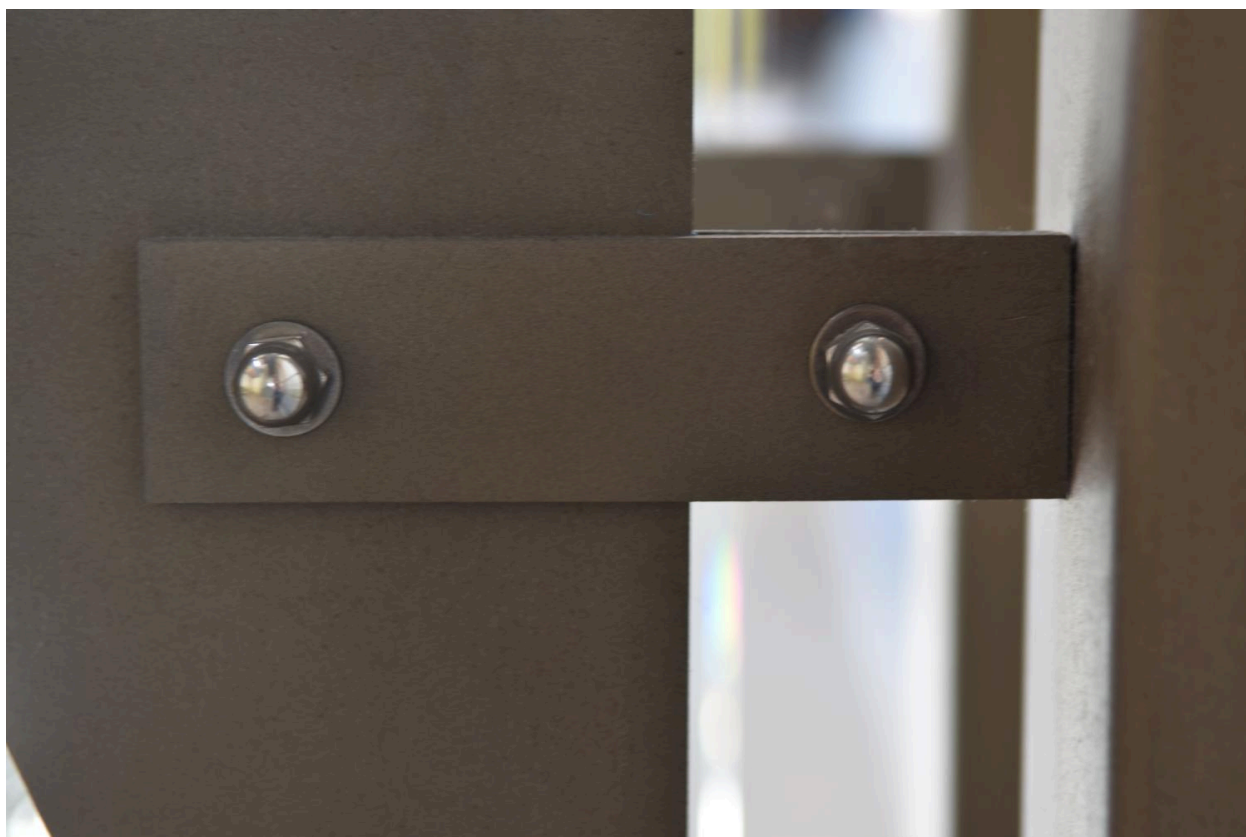
Installation n°5 : détail des pattes de fixation
