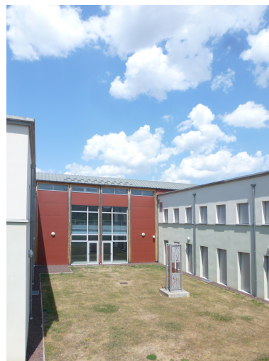
Installation n°3 : vue d'ensemble
