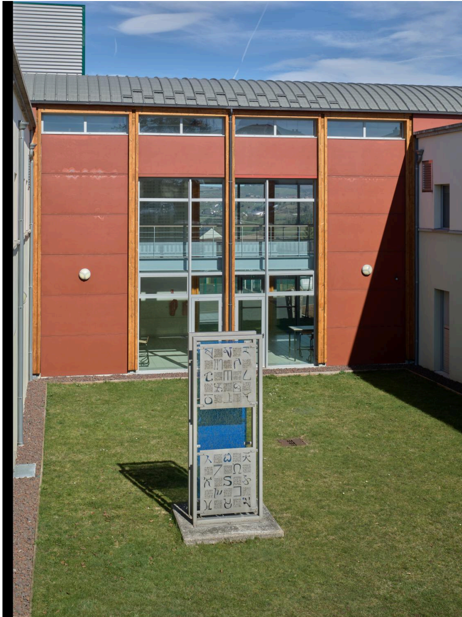
Installation n°2, autre vue d'ensemble
