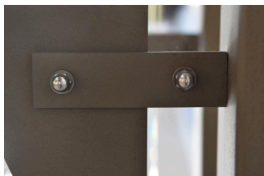
Installation n°5 : détail des pattes de fixation Phot. Catherine Guégan IVR84_20241500059NUCA
