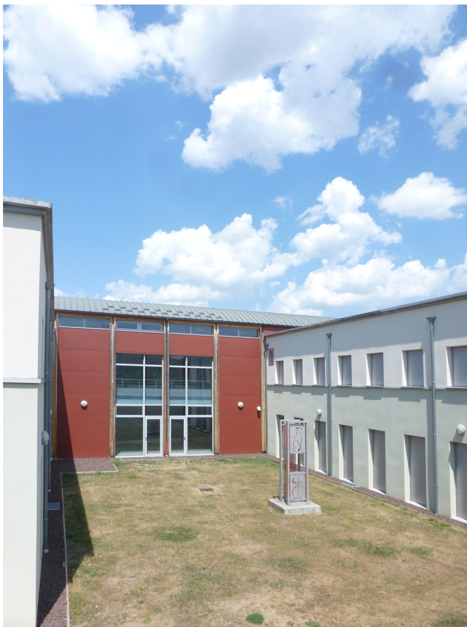
Installation n°3 : vue d'ensemble
