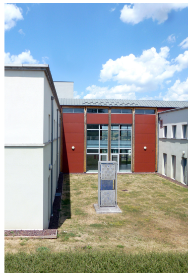
Installation n°2, vue d'ensemble Phot. Bénédicte Renaud-Morand IVR84_20231500152NUCA
