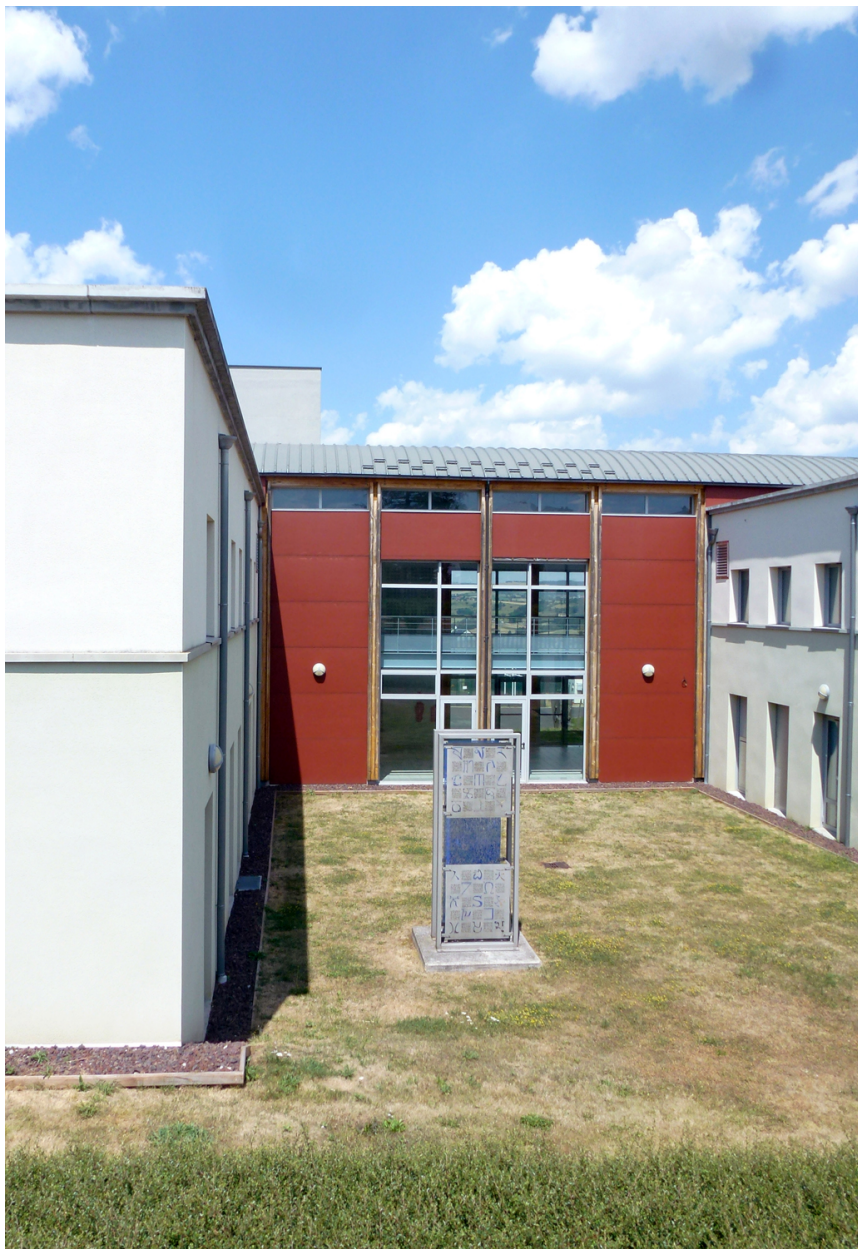
Installation n°2, vue d'ensemble
