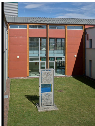
Installation n°2, autre vue d'ensemble
