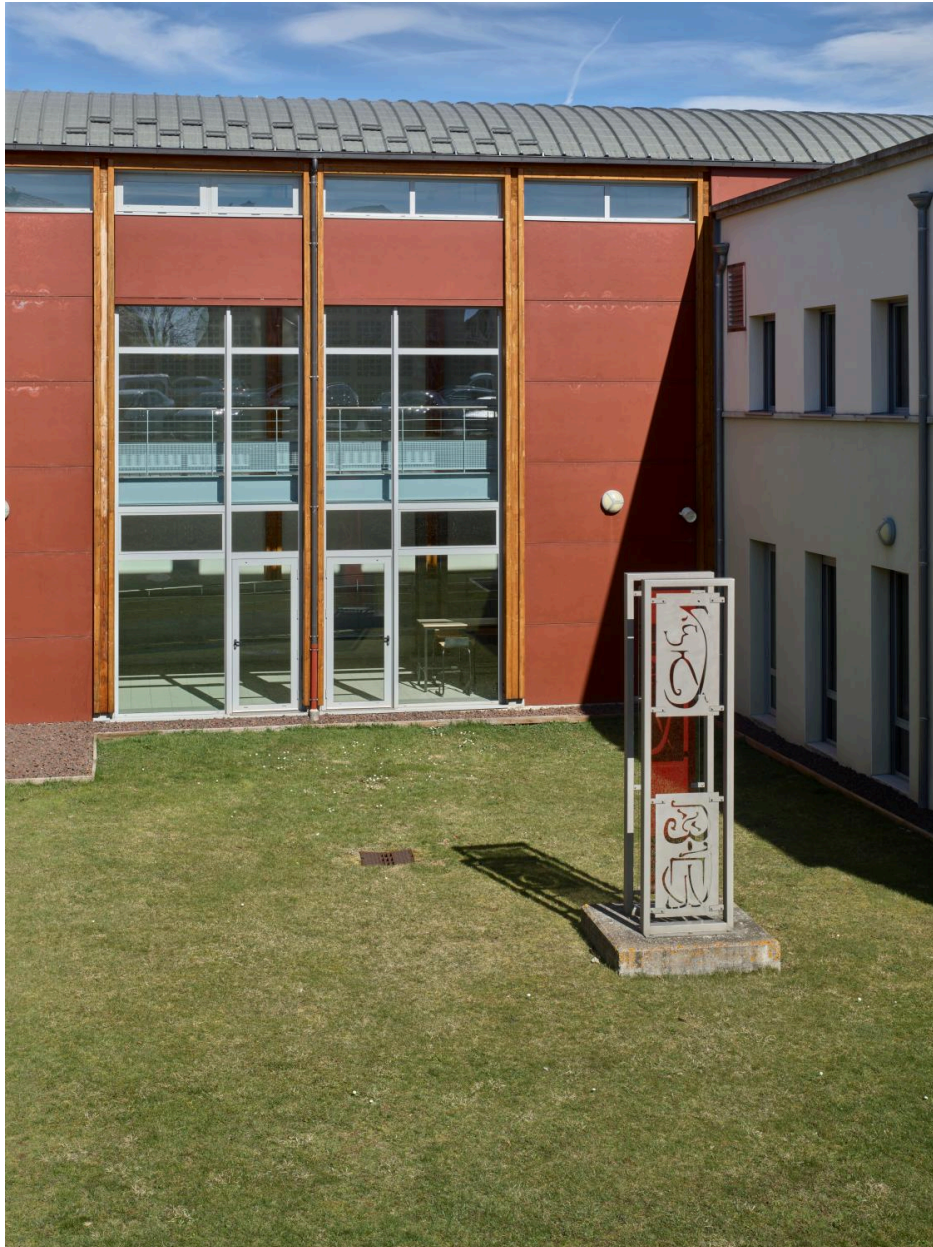
Installation n°3 : autre vue d'ensemble
