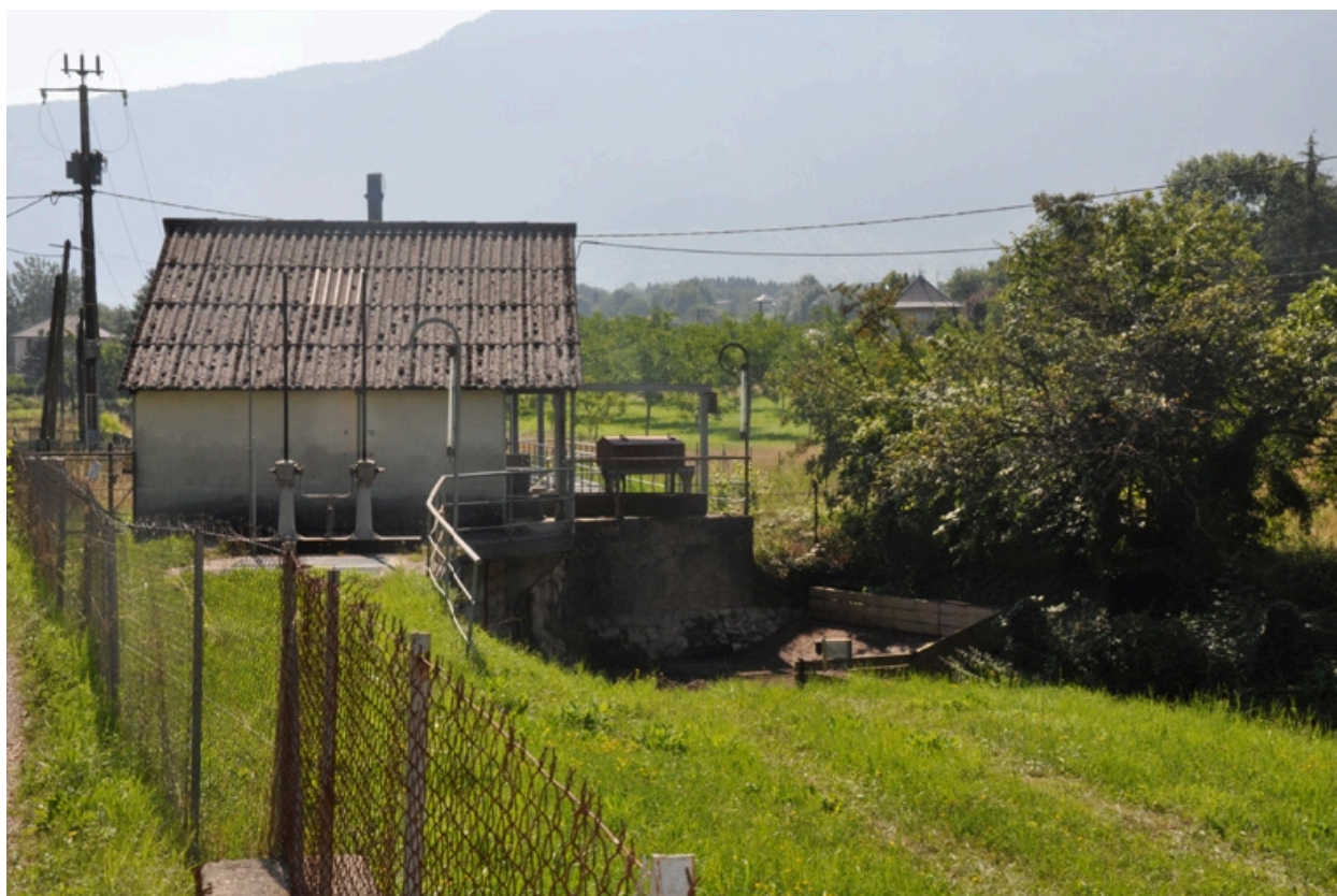
Vue est de la prise d'eau sur le ruisseau du Tier, commune de Saint-Alban-de-Montbel.
