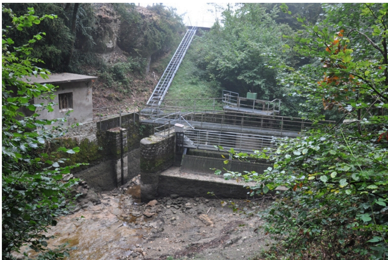
Vue de la prise d'eau sur le Rondelet avec le déversoir et le bâtiment de contrôle.
