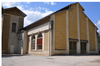
Pignon est de la centrale. Phot. Yannick Milleret IVR82_20097300202NUCA
