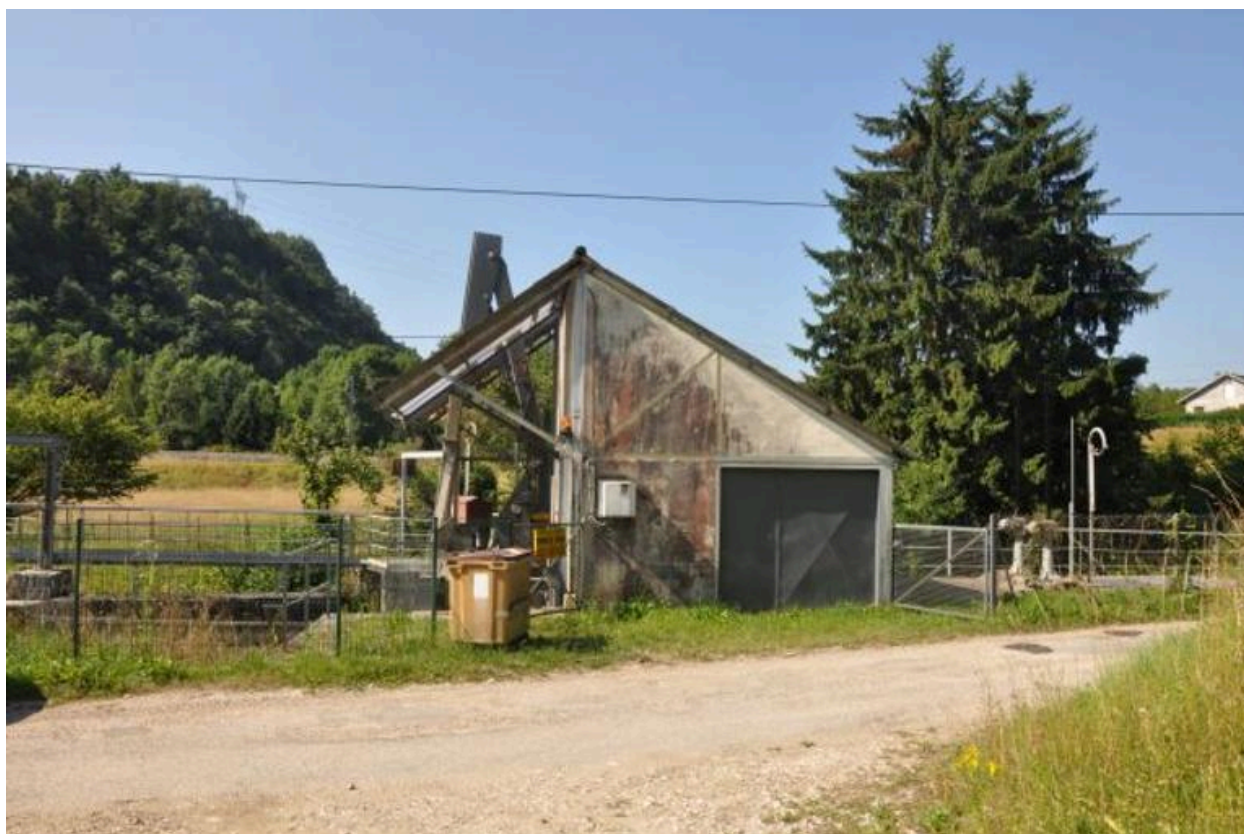
Vue nord de la prise d'eau sur le ruisseau du Tier, commune de Saint-Alban-de-Montbel.
