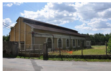
Vue générale est de la centrale. Phot. Yannick Milleret
