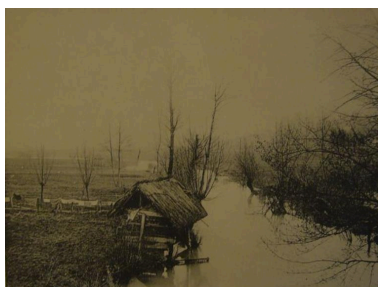
Vue du ruisseau du Tier avant la prise d'eau pour la centrale (Album de la Chambre Syndicale des Forces hydrauliques).
