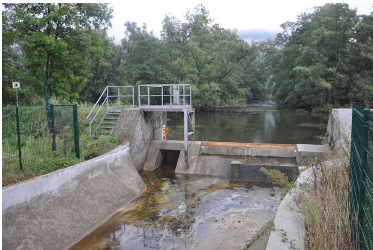
Canal de fuite du bassin de compensation se déversant dans la rivière du Guiers.
