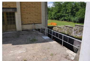
Arrivée de la consuite forcée dans la centrale. Phot. Yannick Milleret IVR82_20097300203NUCA
