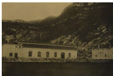
Vue générale sud de la centrale hydroélectrique (Album de la Chambre Syndicale des Forces hydrauliques).
