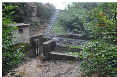
Vue de la prise d'eau sur le Rondelet avec le déversoir et le bâtiment de contrôle. Phot. Yannick Milleret IVR82_20097300219NUCA
