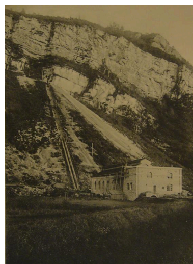
Vue de la centrale et des conduites forcées en construction (Album de la Chambre Syndicale des Forces hydrauliques).
