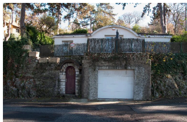
Ancienne entrée piétonne sur le boulevard de la Roche-du-Roi Phot. Denys Harreau
