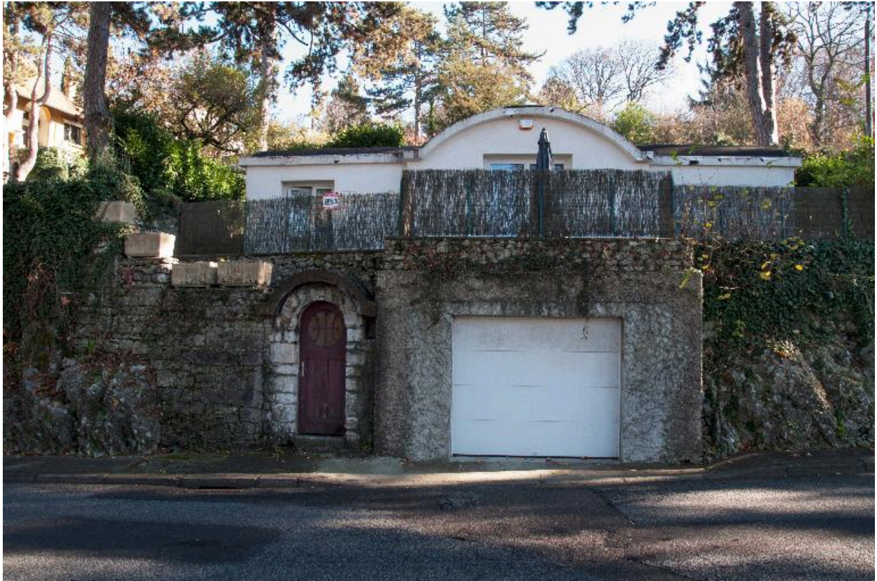
Ancienne entrée piétonne sur le boulevard de la Roche-du-Roi
