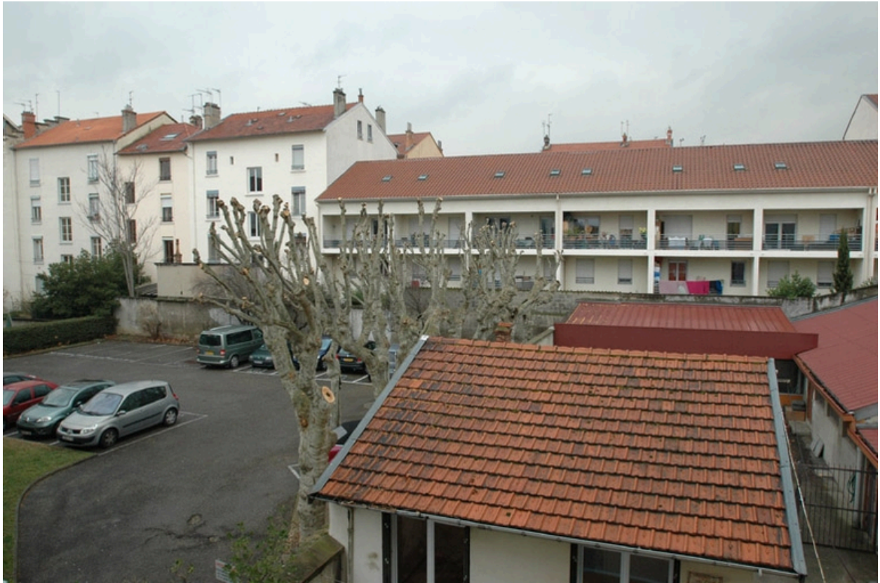
Entrepôt et parking, vue sud ouest.
