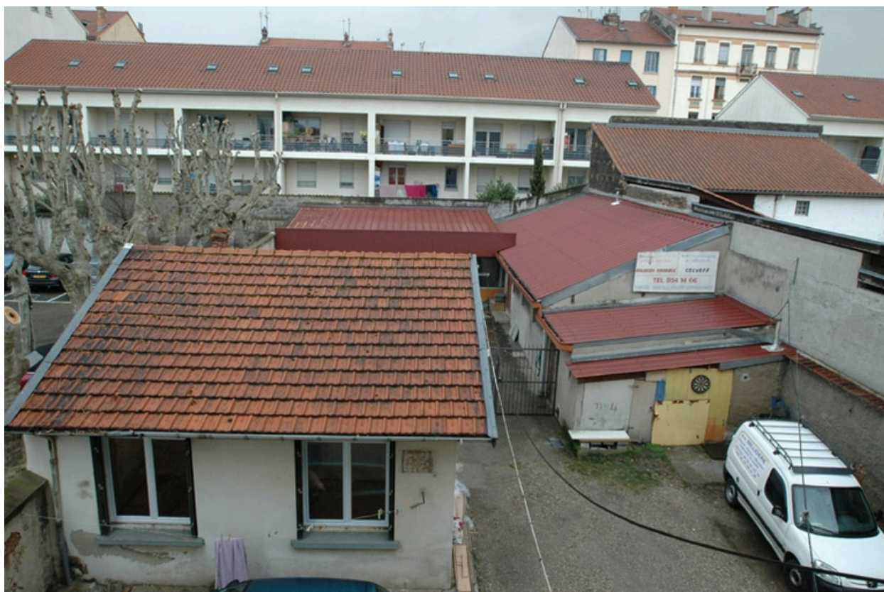
Entrepôt de l'ancienne usine Cazes, vue ouest.
