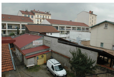
Entrepôt de l'ancienne usine Cazes, vue nord-ouest. Phot. Nadine Halitim-Dubois IVR82_20096901663NUCA
