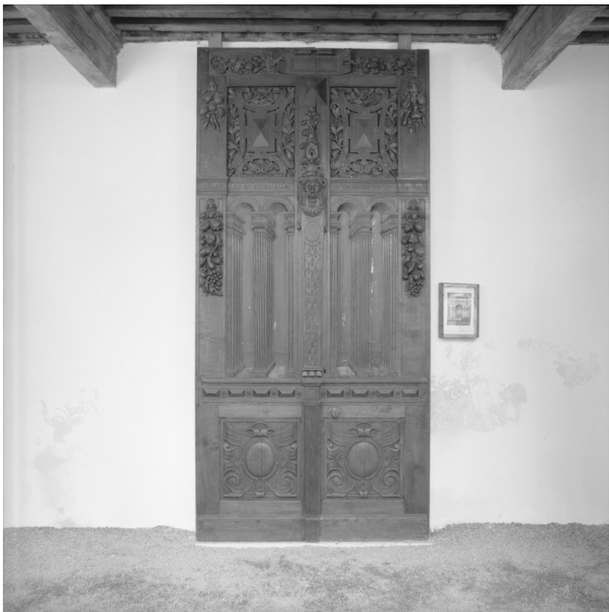
Fermeture de la baie centrale du nymphée, actuellement remontée en vantaux de porte et placée dans la galerie, au rez-de-chaussé.
