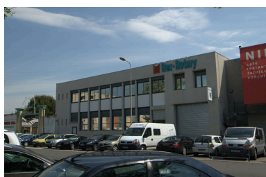
Vue générale ouest Phot. Nadine Halitim-Dubois IVR82_20086900453NUCA
