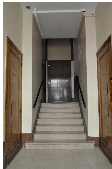
Vue intérieure : le vestibule et la volée d'escalier isolée joignant la tour d'escalier et d'ascenseur Phot. Catherine Guégan IVR82_20156901130NUCA
