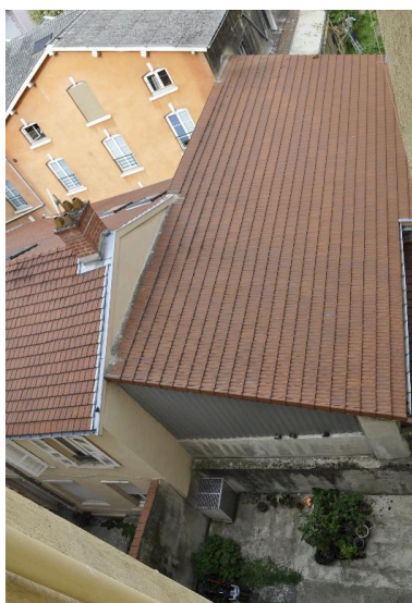
Bâtiment sur cour (entrepôt ?) Phot. Catherine Guégan IVR82_20156901133NUCA
