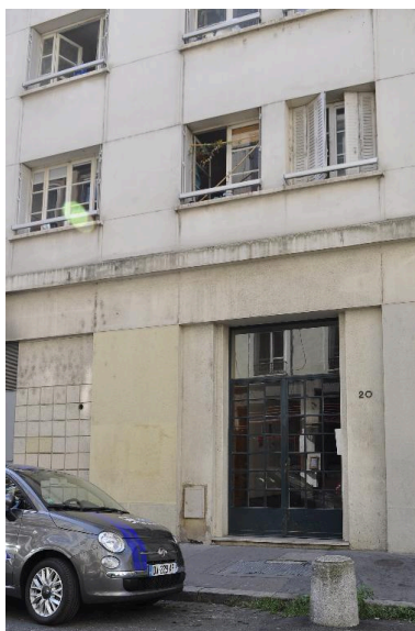
Vue rapprochée de la porte d'entrée Phot. Catherine Guégan IVR82_20156901129NUCA
