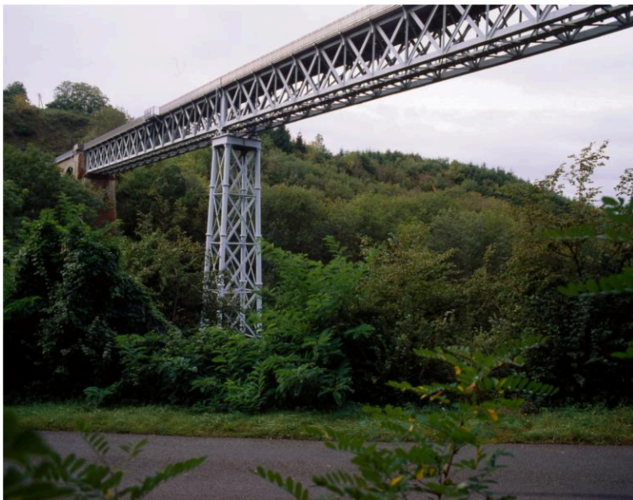
Vue du viaduc depuis la route en contrebas.
