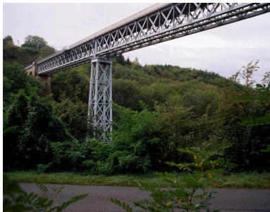
Vue du viaduc depuis la route en contrebas. Phot. Roger Choplain, Phot. Roland Maston IVR83_19920300026XA
