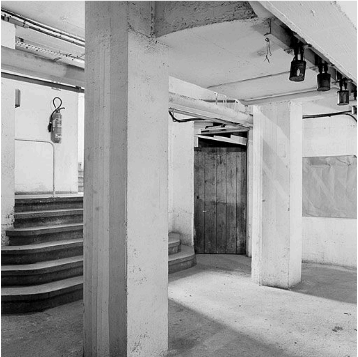
Vue de l'escalier d'arrivée dans les caves
