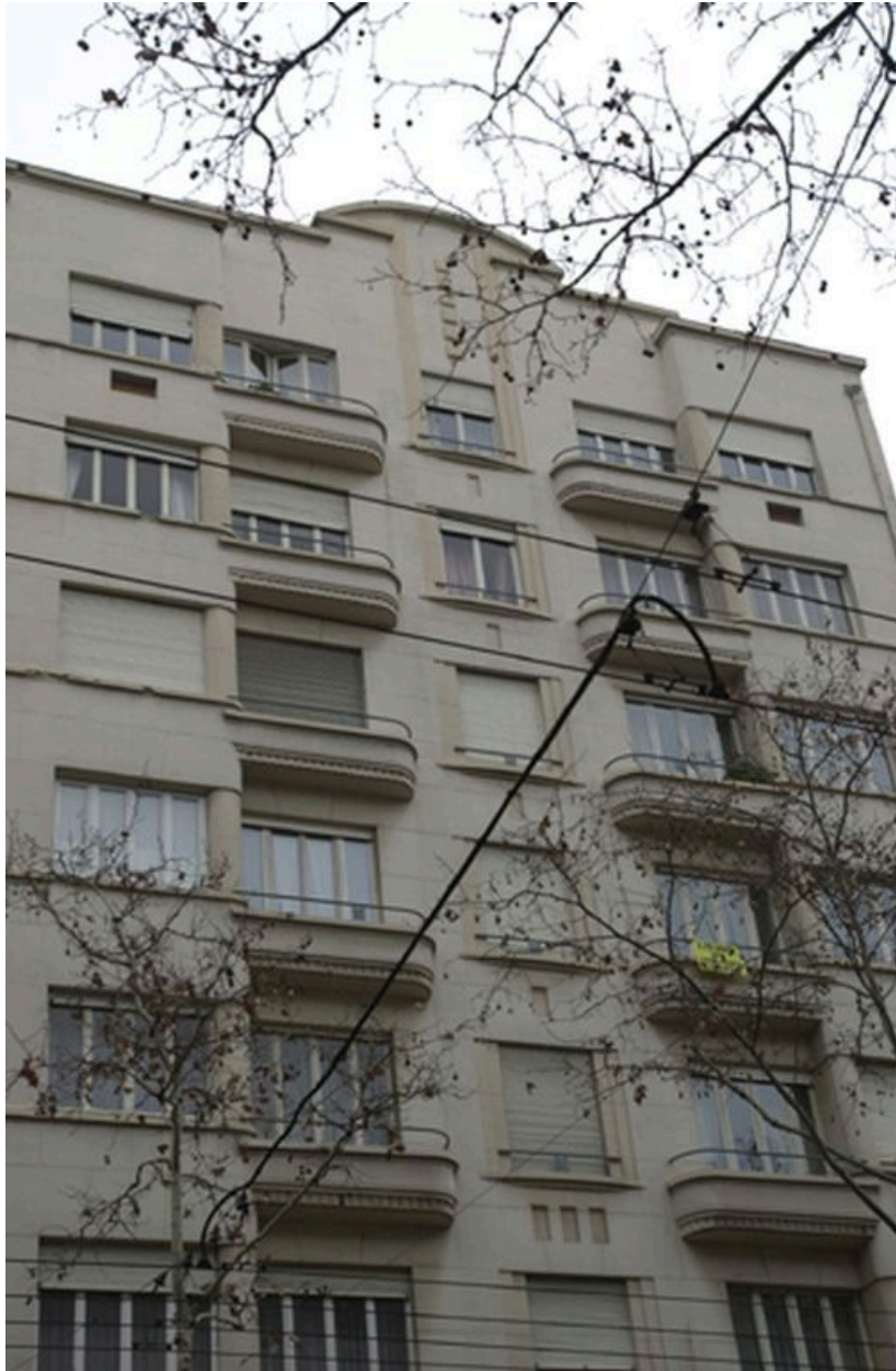
Détail de la travée centrale de la façade (vers le haut)
