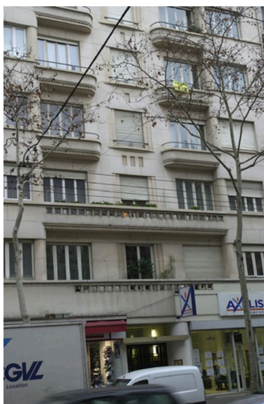
Vue de la travée centrale de la façade sur rue Phot. Maryannick Chalabi IVR82_20046904306NUCA
