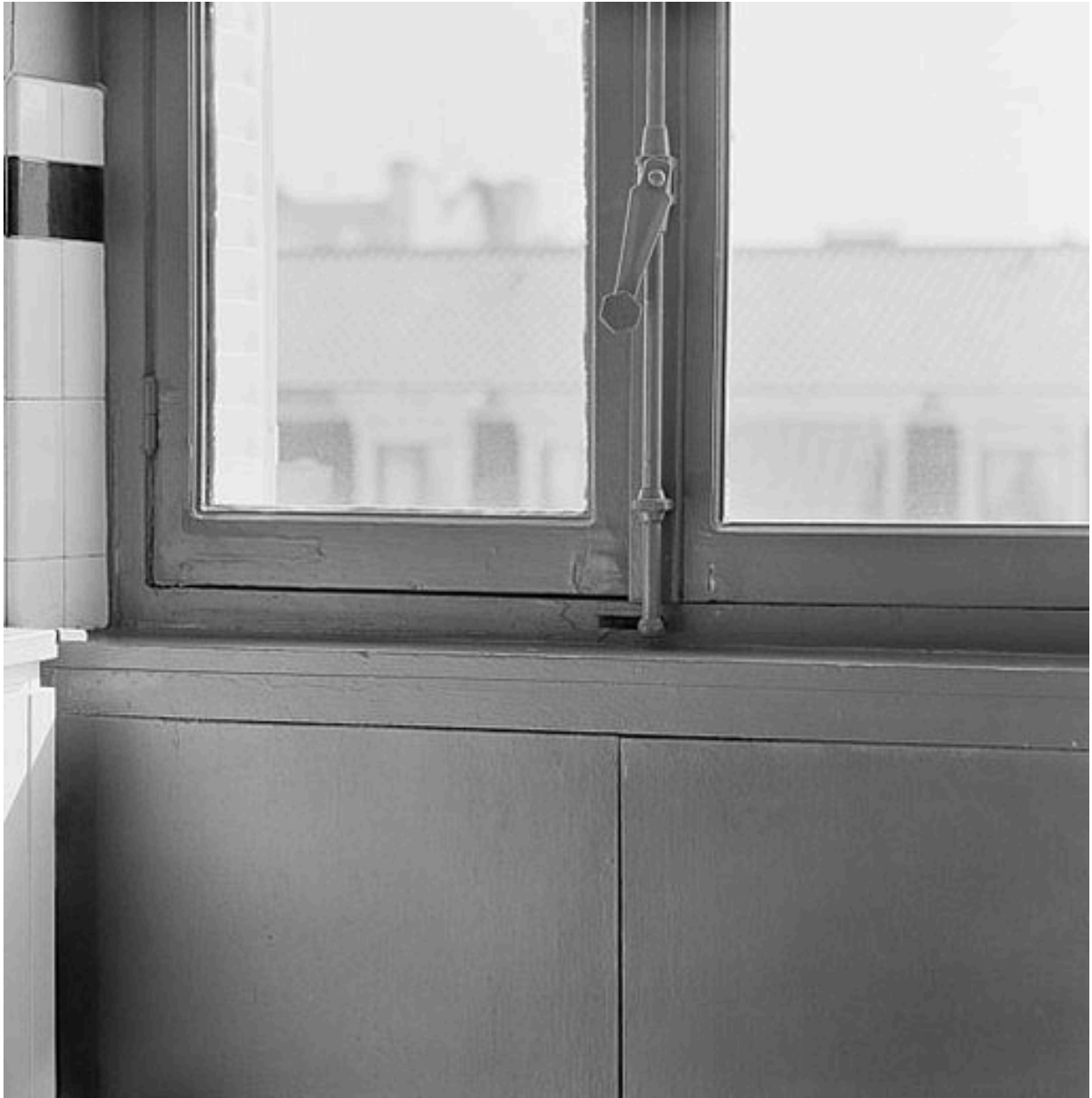
Espagnolette, fenêtre de la cuisine d'un appartement
