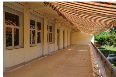
Terrasse du 1er étage, aile gauche Phot. Denys Harreau IVR82_20147300574NUCA
