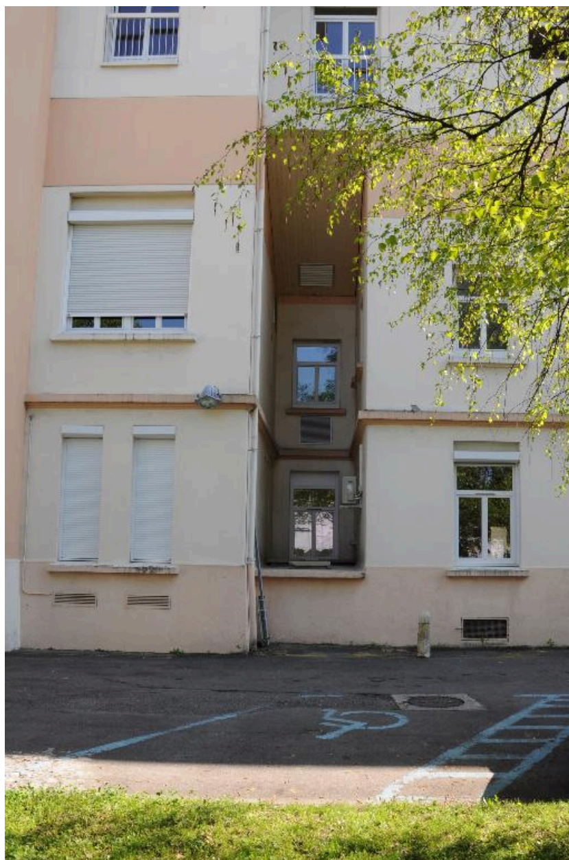
Façade postérieure, puits de lumière
