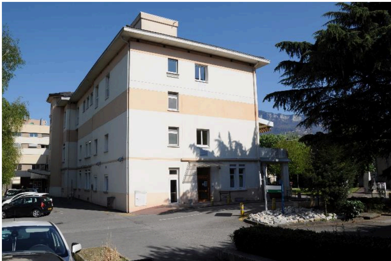
Façades postérieure et latérale
