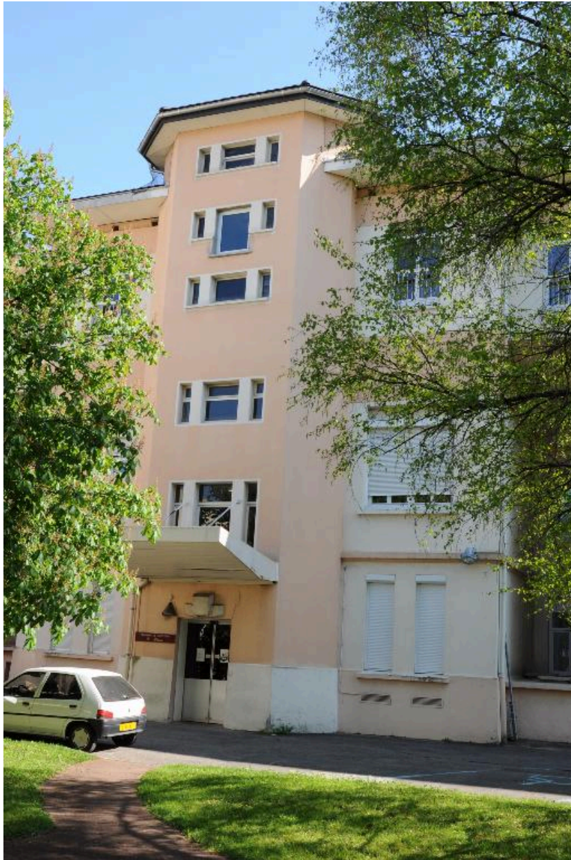
Façade postérieure, avant-corps abritant l'escalier intérieur
