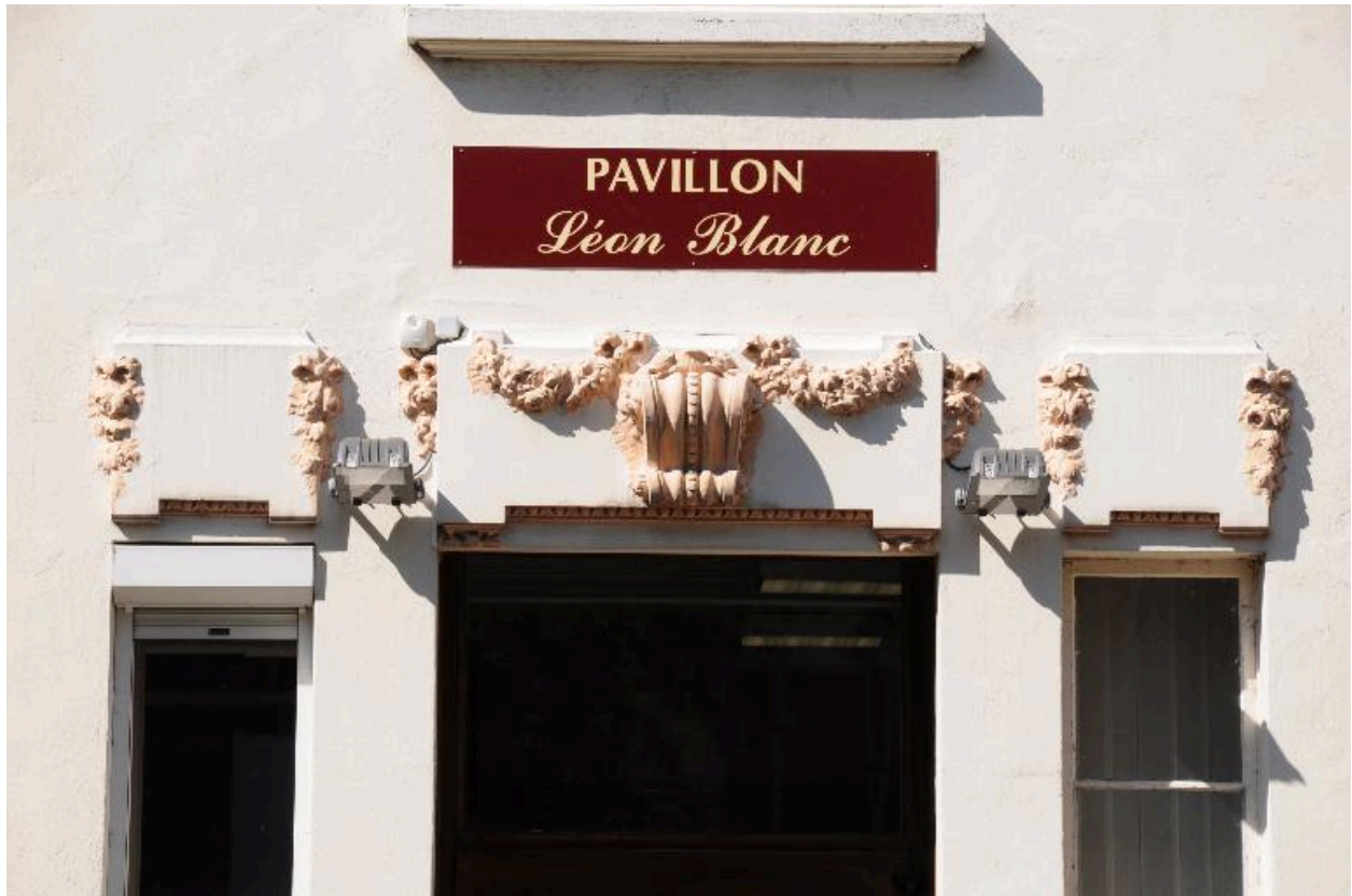
Décor au-dessus de la porte d'entrée, façade principale
