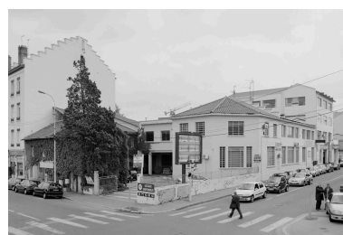
Vue sud-ouest angle Lortet et Yves Farge Phot. Didier Gourbin IVR82_20066900090X
