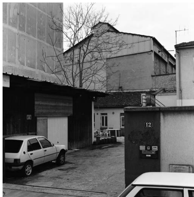
Vue générale nord-est Phot. Didier Gourbin IVR82_20036901789X
