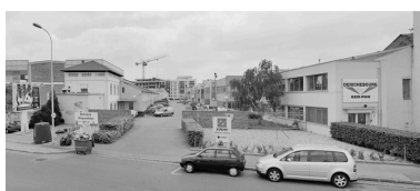
Vue générale ouest du site Phot. Didier Gourbin IVR82_20066900092X
