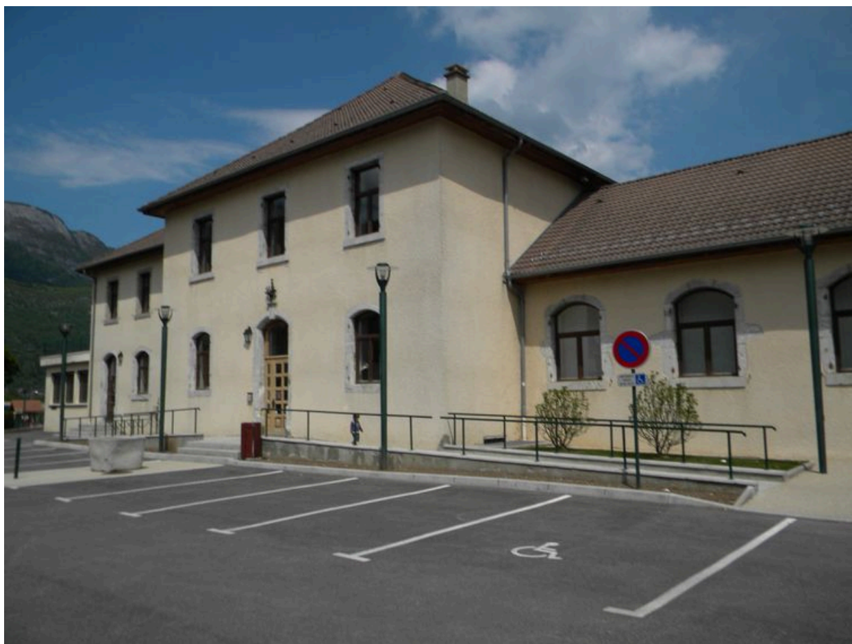
Vue générale de la façade principale.
