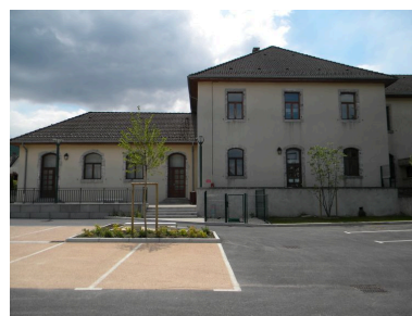
Vue de la façade arrière. Phot. Jérôme Daviet IVR82_20117400922NUCA
