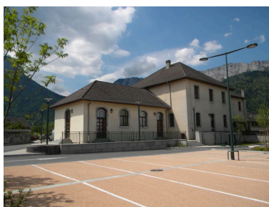
Vue de trois-quarts arrière depuis l'actuelle mairie. Phot. Jérôme Daviet IVR82_20117400921NUCA
