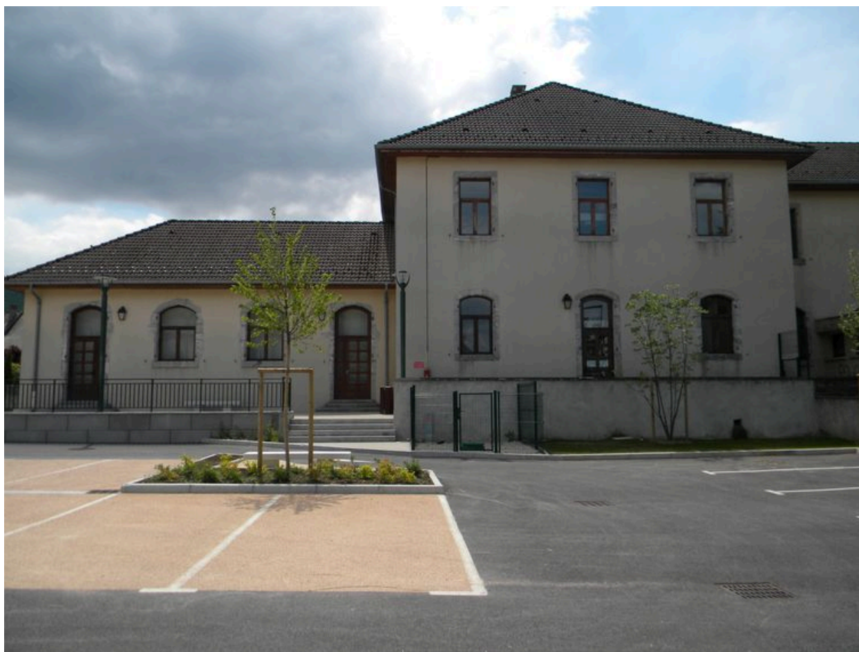
Vue de la façade arrière.
