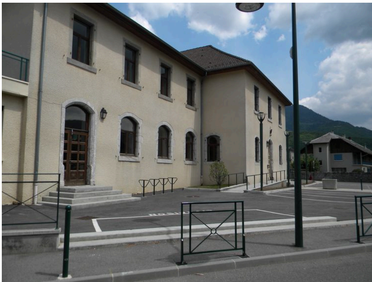
Vue de l'aile ouest de l'ancienne école avec la partie surélevée.
