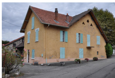
Le corps d'habitation, vue de trois- quart prise depuis le sud-ouest Phot. Denys Harreau IVR82_20137300913NUCA
