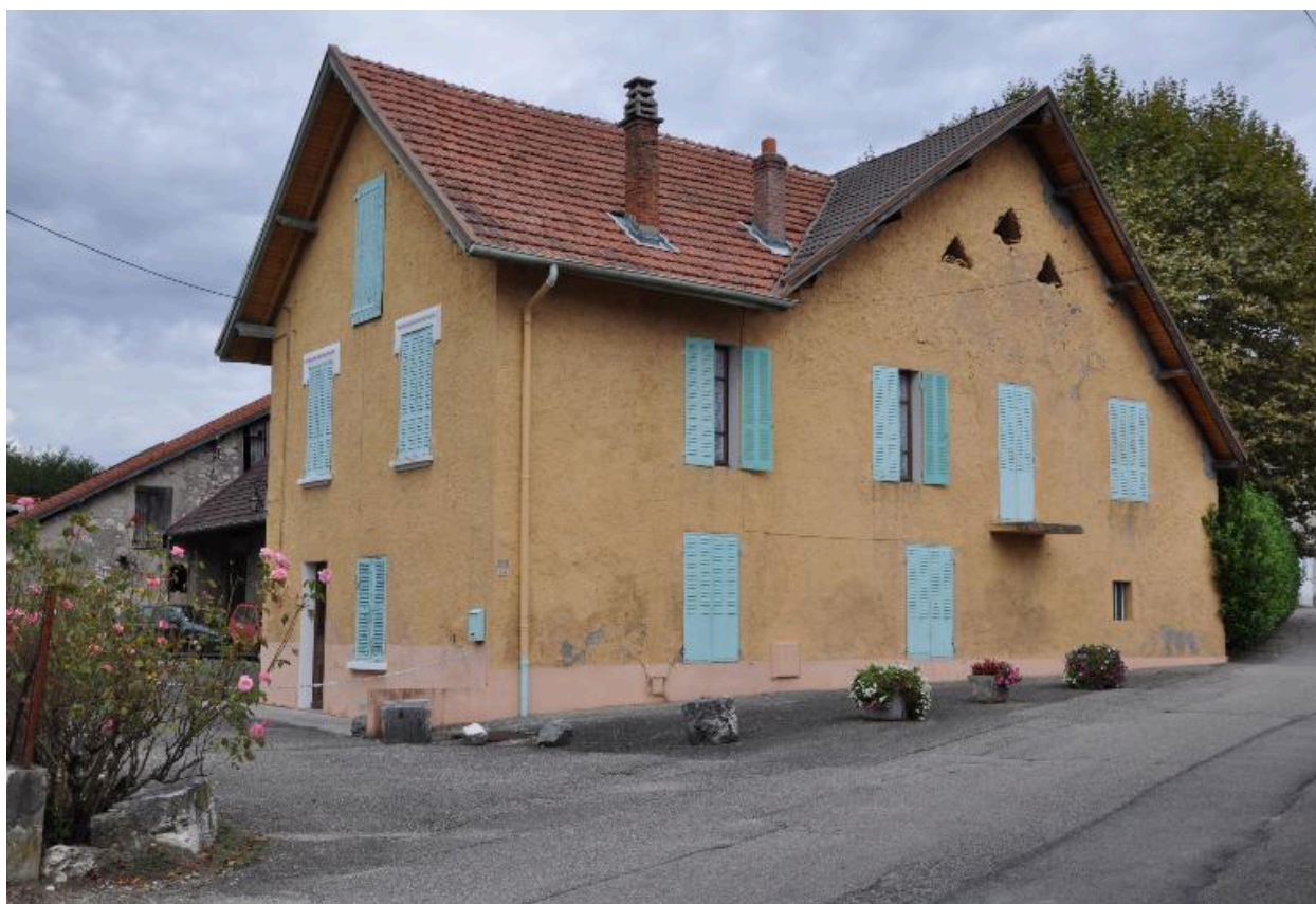
Le corps d'habitation, vue de trois-quart prise depuis le sud-ouest
