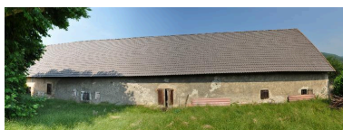
Vue générale des dépendances agricoles depuis l'est Phot. François Fouger IVR82_20147300809NUCA
