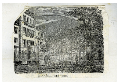
Etat ancien Repro. François Fouger IVR82_20117300674NUCB
