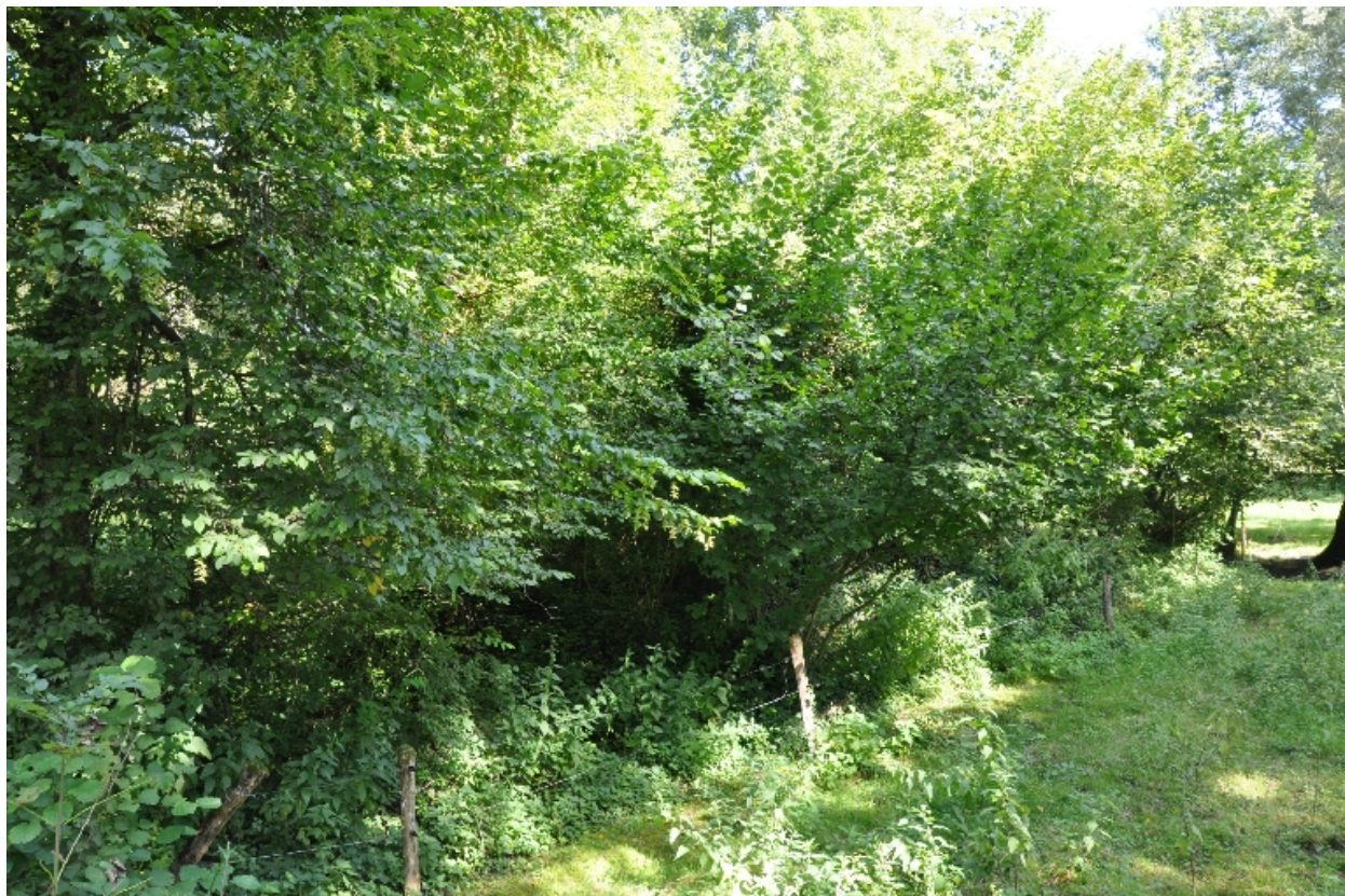
Vue générale des vestiges des anciens artifices envahi par la végétation
