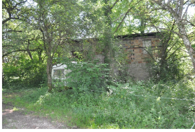
Vue du bâtiment récent présent sur le site Phot. Yannick Milleret IVR82_20117302091NUCA
