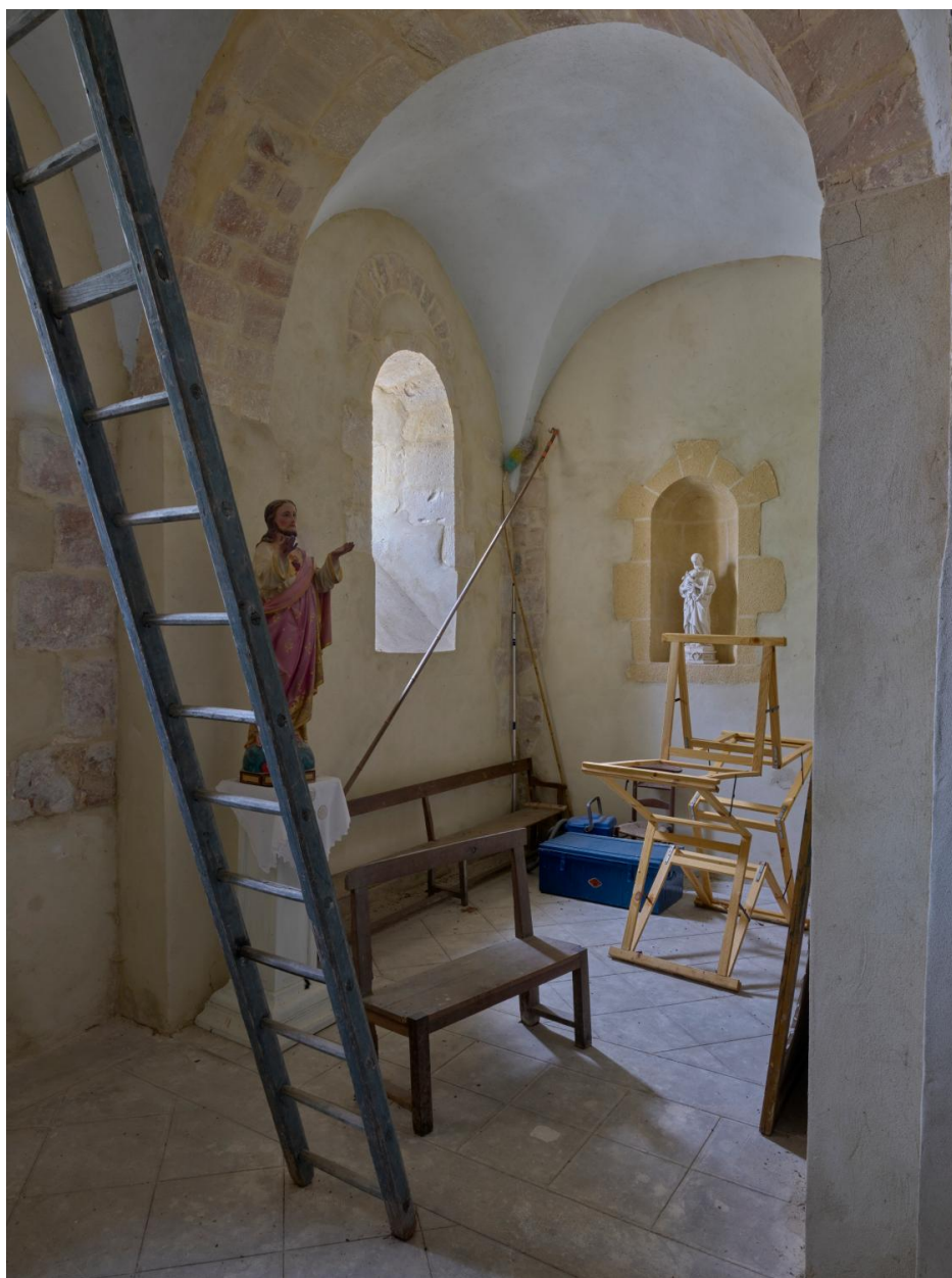
Vue de l'angle nord-est de la chapelle attenante, formant en partie la base du clocher
