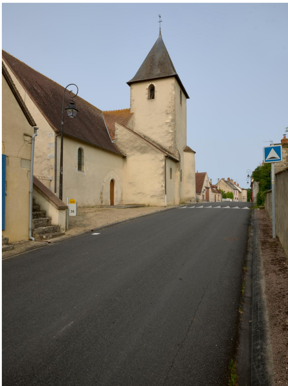
Vue de la façade septentrionale de l'église.
