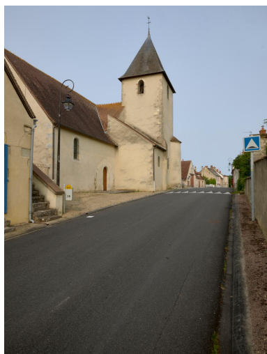
Vue de la façade septentrionale de l'église. Phot. Christian Parisey IVR84_20230300153NUC4A
