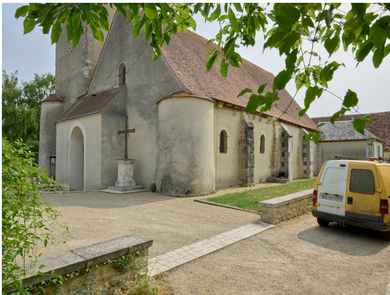
Vue de l'angle sud ouest de l'église
