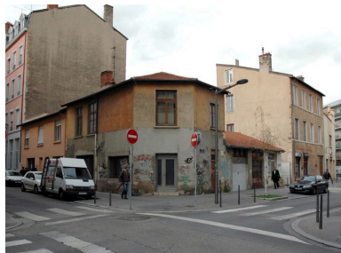
Vue d'ensemble, depuis le sud-est Phot. Catherine Guégan IVR82_20076902221NUCA
