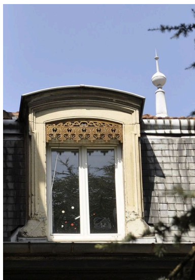
Lucarne collatérale Phot. Julien Defillon IVR82_20106901121NUCA
