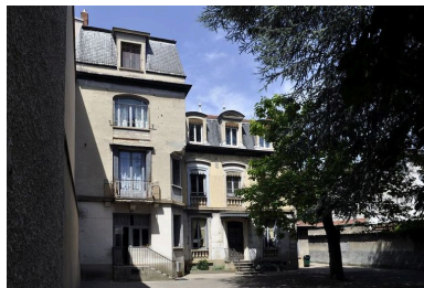
Façade antérieure Phot. Julien Defillon IVR82_20106901120NUCA
