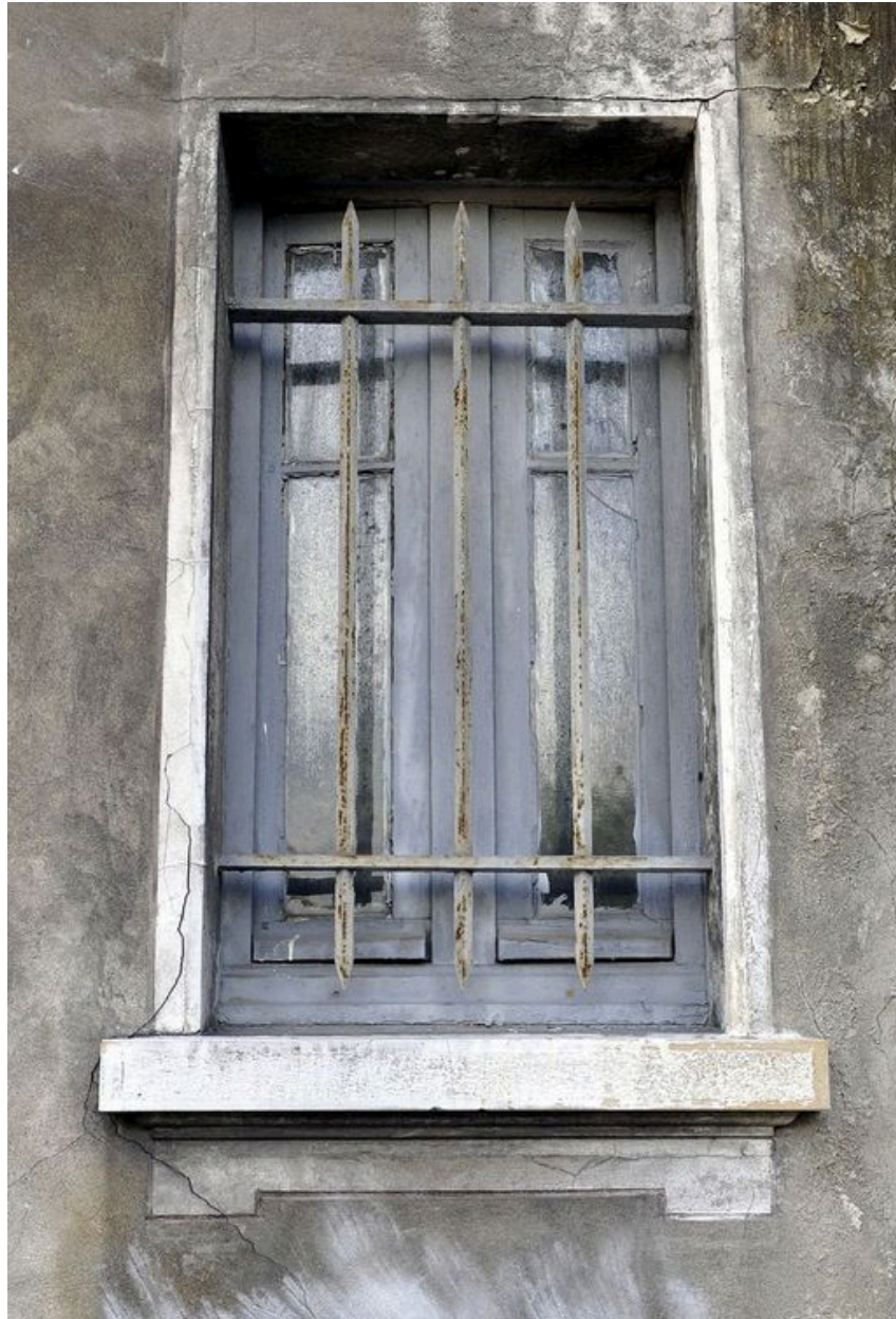
Façade postérieure, baie du rez-de-chaussée
