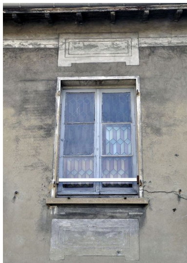
Façade postérieure : baie du premier étage Phot. Julien Defillon IVR82_20106901058NUCA
