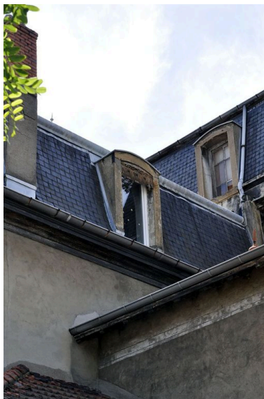
Façade postérieure : lucarne Phot. Julien Defillon IVR82_20106901112NUCA
