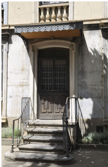
Porte avec perron Phot. Julien Defillon IVR82_20106901117NUCA
