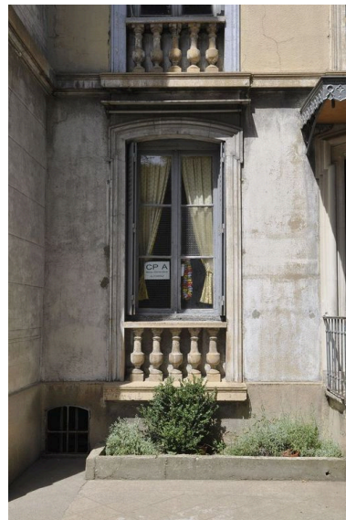
Baie du rez-de-chaussée Phot. Julien Defillon IVR82_20106901118NUCA
