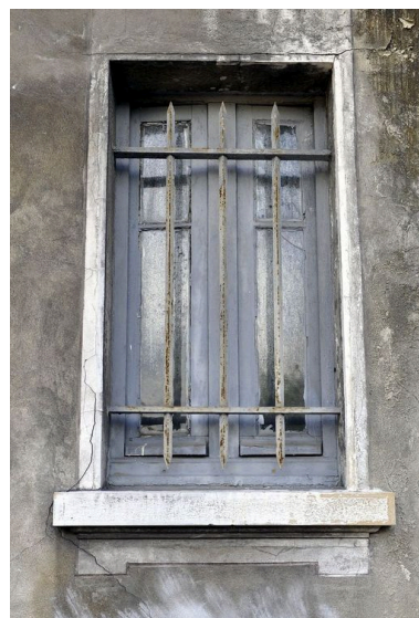
Façade postérieure, baie du rez-de-chaussée Phot. Julien Defillon IVR82_20106901114NUCA
