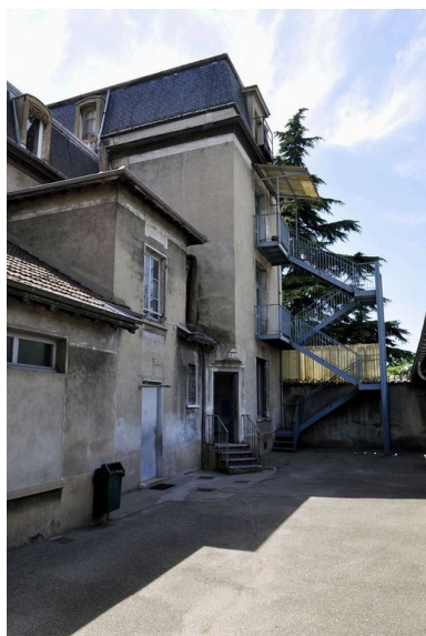
Façade postérieure, escalier de service Phot. Julien Defillon IVR82_20106901060NUCA
