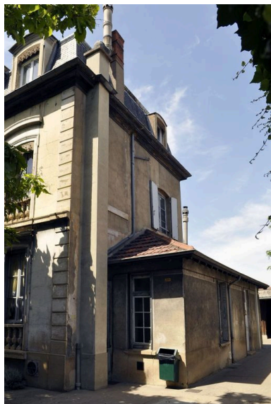
Façade latérale Phot. Julien Defillon IVR82_20106901116NUCA
