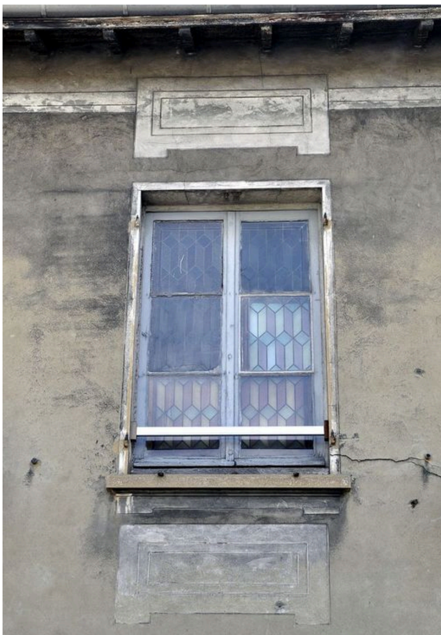
Façade postérieure : baie du premier étage
