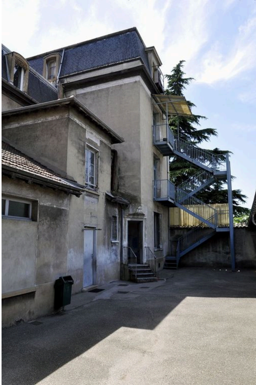
Façade postérieure, escalier de service
