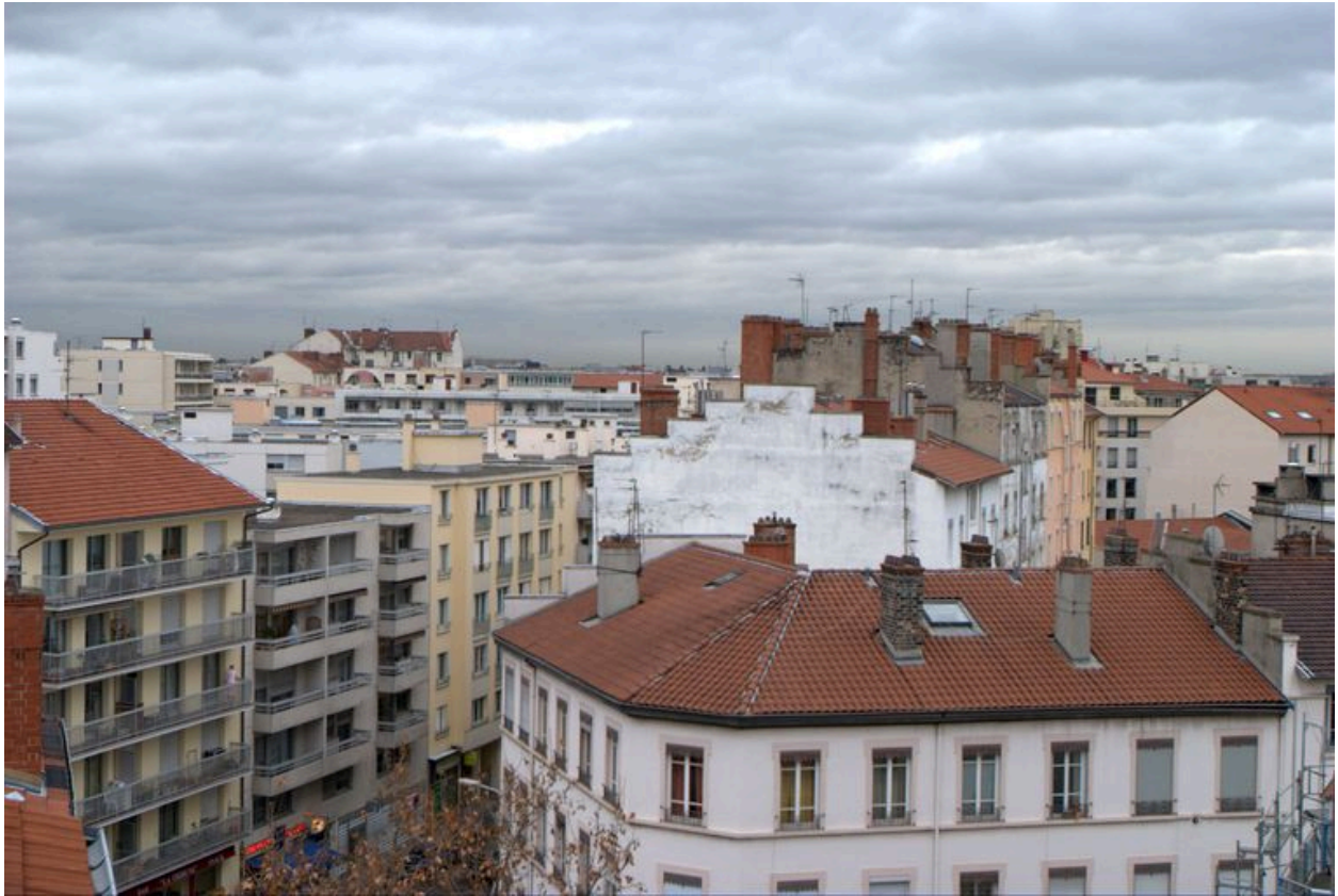
Elévation grande rue de la Guillotière depuis le toit du 67 rue Domer au sud-ouest
