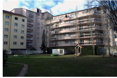
Elévation postérieure Phot. Maryannick Chalabi IVR82_20116904084NUCA
