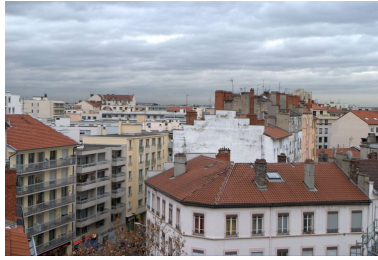
Elévation grande rue de la Guillotière depuis le toit du 67 rue Domer au sud-ouest Phot. Maryannick Chalabi IVR82_20096901299NUCA
