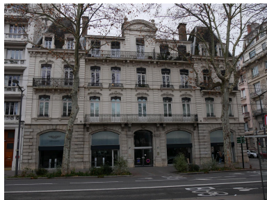
Vue d'ensemble du bâtiment des bureaux, Ets Faurax et Cie Phot. Nadine Halitim-Dubois IVR84_20256901470NUCA
