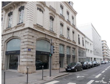
Ets Faurax et Cie vue angle rue Barrême Phot. Nadine Halitim-Dubois IVR84_20256901471NUCA
