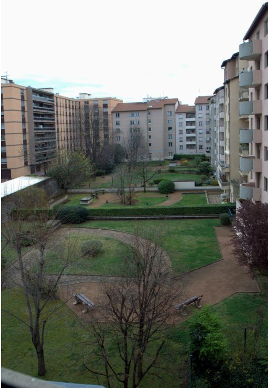
Elévation postérieure et coeur d'îlot, depuis le nord
