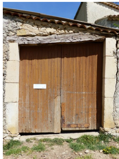
Remise sud-ouest. Elévation sud, porte. Phot. Alexeï Laurent IVR84_20162600597NUCA
