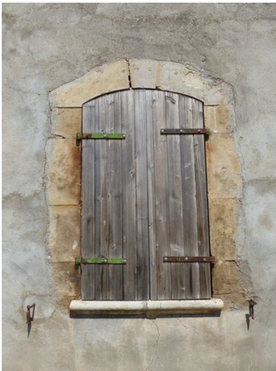
Partie ouest. Pignon sud, deuxième niveau. Fenêtre.
