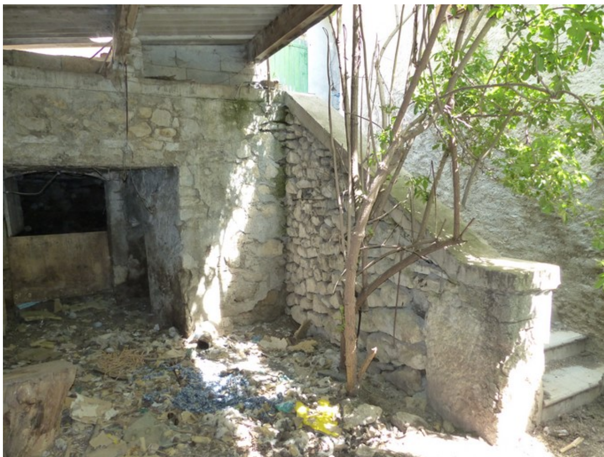
Partie ouest. Elévation sud, premier niveau. Escalier extérieur et palier filant.
