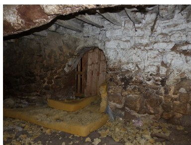
Partie ouest. Etage de soubassement, étable. Angle nord-est. Phot. Alexeï Laurent IVR84_20162600586NUCA
