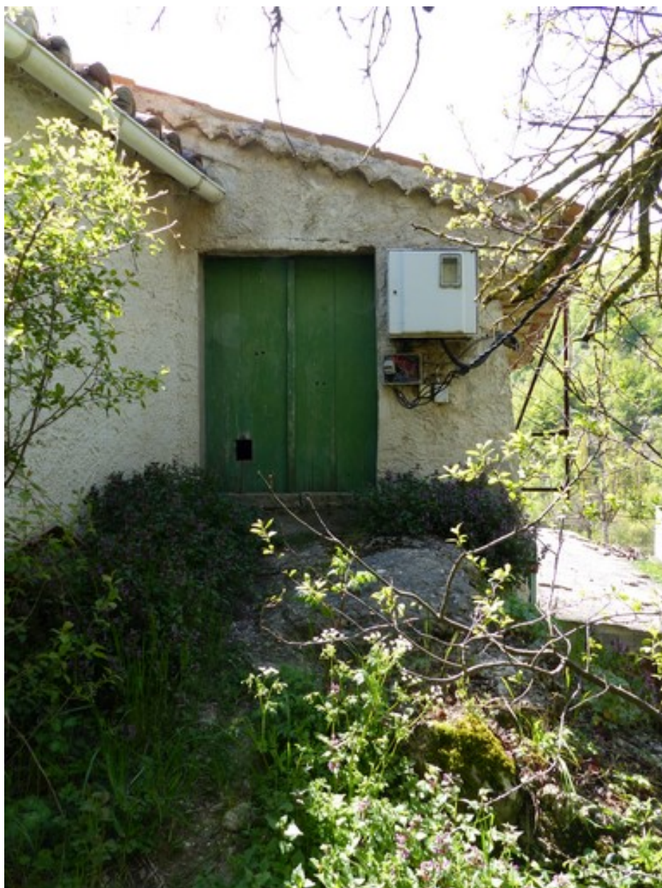
Partie ouest. Elévation nord, baie fenièrè.
