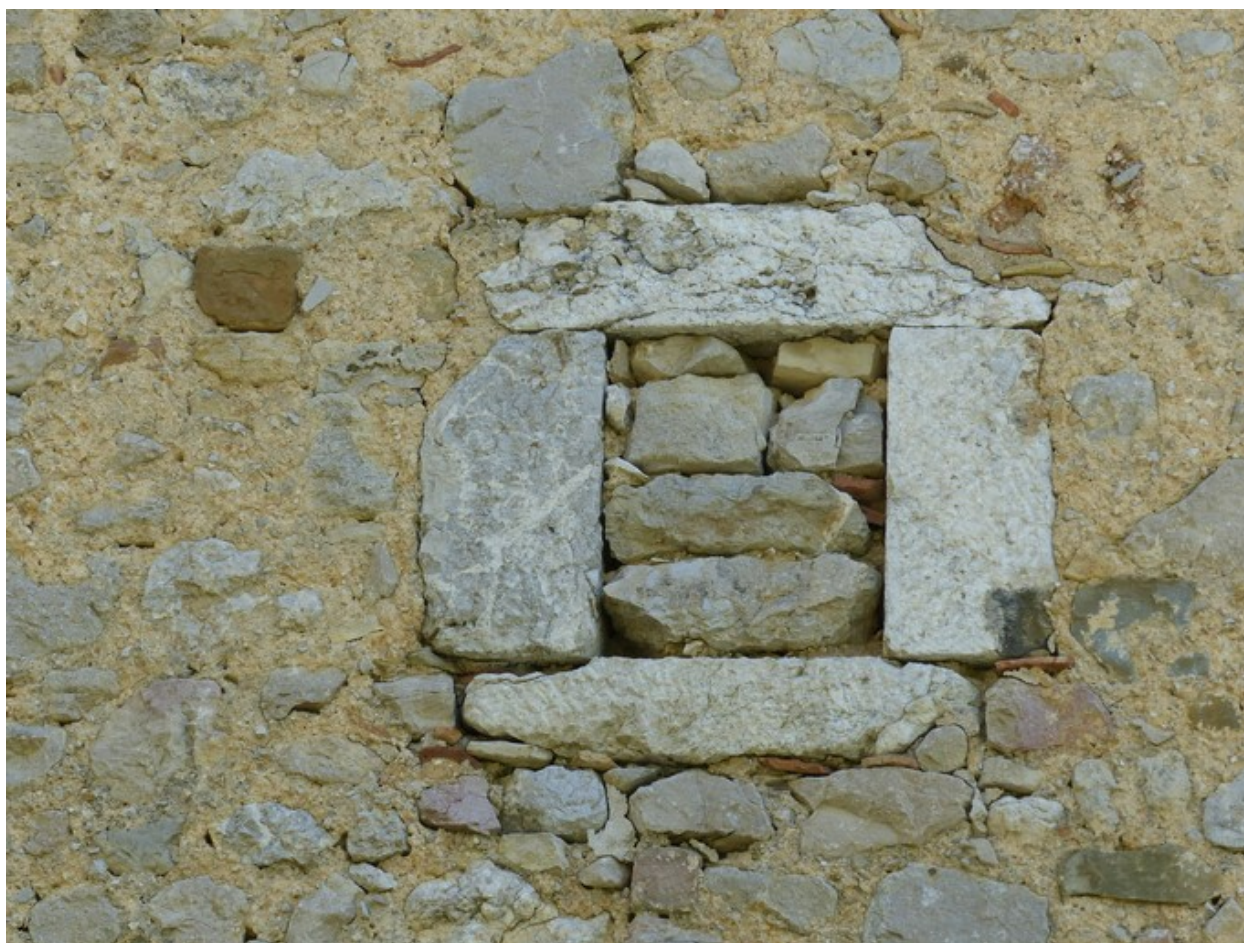
Partie ouest. Elévation ouest, deuxième niveau. Fenêtre.
