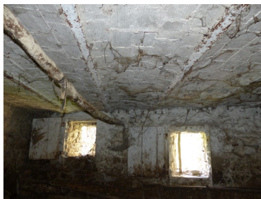
Partie ouest. Etage de soubassement, étable. Couvrement en voûtains. Phot. Alexeï Laurent IVR84_20162600596NUCA
