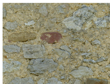
Partie ouest. Elévation ouest, détail de la maçonnerie. Phot. Alexeï Laurent IVR84_20162600591NUCA
