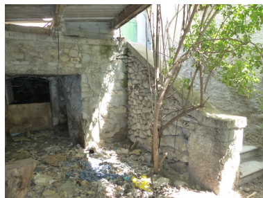
Partie ouest. Elévation sud, premier niveau. Escalier extérieur et palier filant. Phot. Alexeï Laurent IVR84_20162600584NUCA
