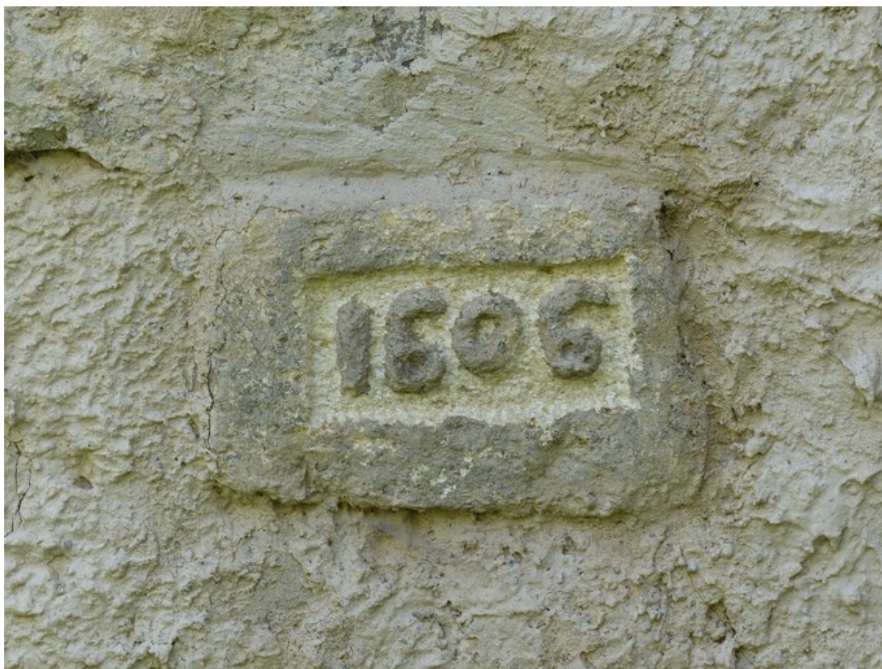
Partie est. Elévation nord, date portée (1606).
