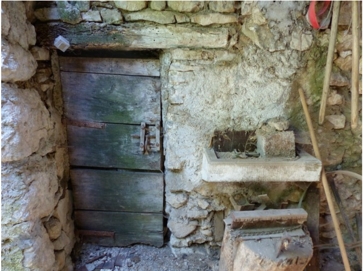
Partie est. Elévation ouest, premier niveau. Porte et trappe de l'étable à cochon.
