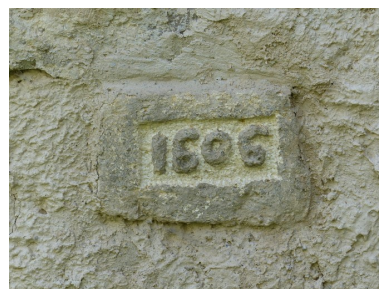
Partie est. Elévation nord, date portée (1606). Phot. Alexeï Laurent IVR84_20162600594NUCA
