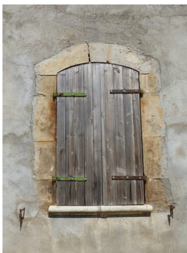
Partie ouest. Pignon sud, deuxième niveau. Fenêtre. Phot. Alexeï Laurent IVR84_20162600587NUCA
