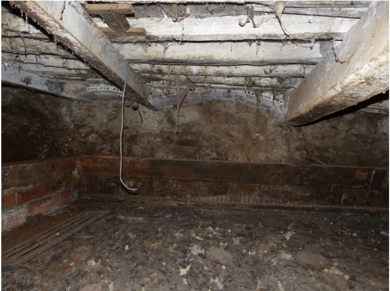
Partie ouest. Etage de soubassement, étable. Mur nord.
