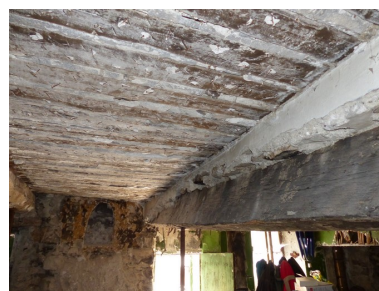
Partie ouest. Rez-de-chaussée surélevé, logis. Plafond. Phot. Alexeï Laurent IVR84_20162600588NUCA
