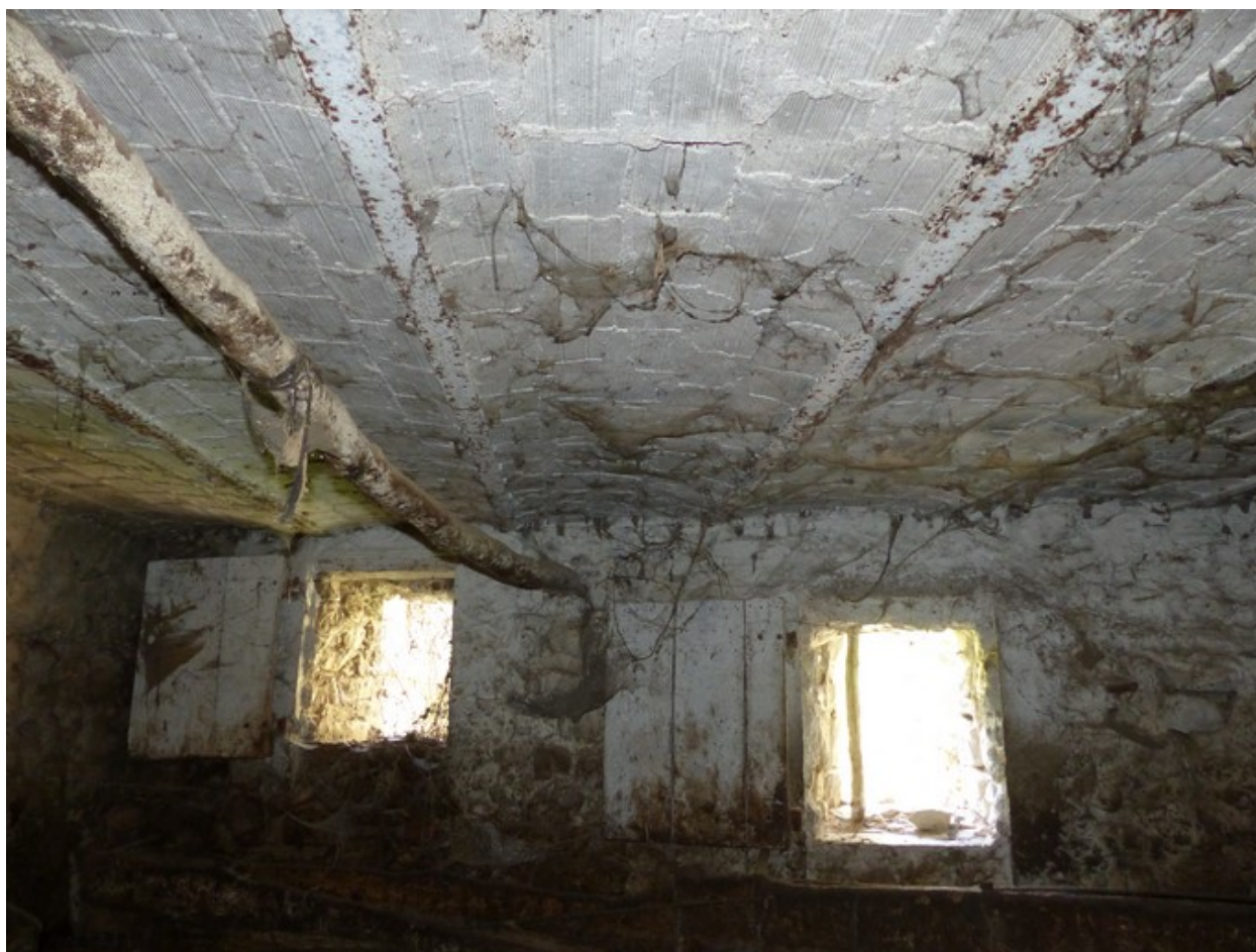
Partie ouest. Etage de soubassement, étable. Couvrement en voûtain.
