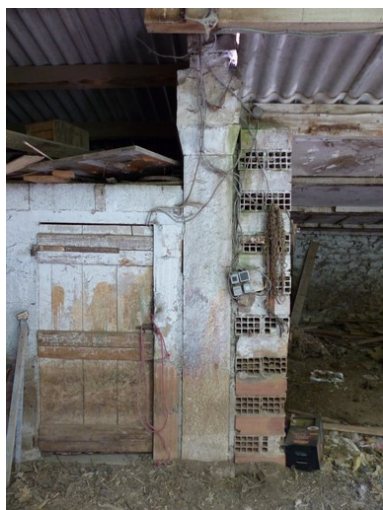
Remise sud-ouest. Pilier monolithe. Phot. Alexeï Laurent IVR84_20162600598NUCA
