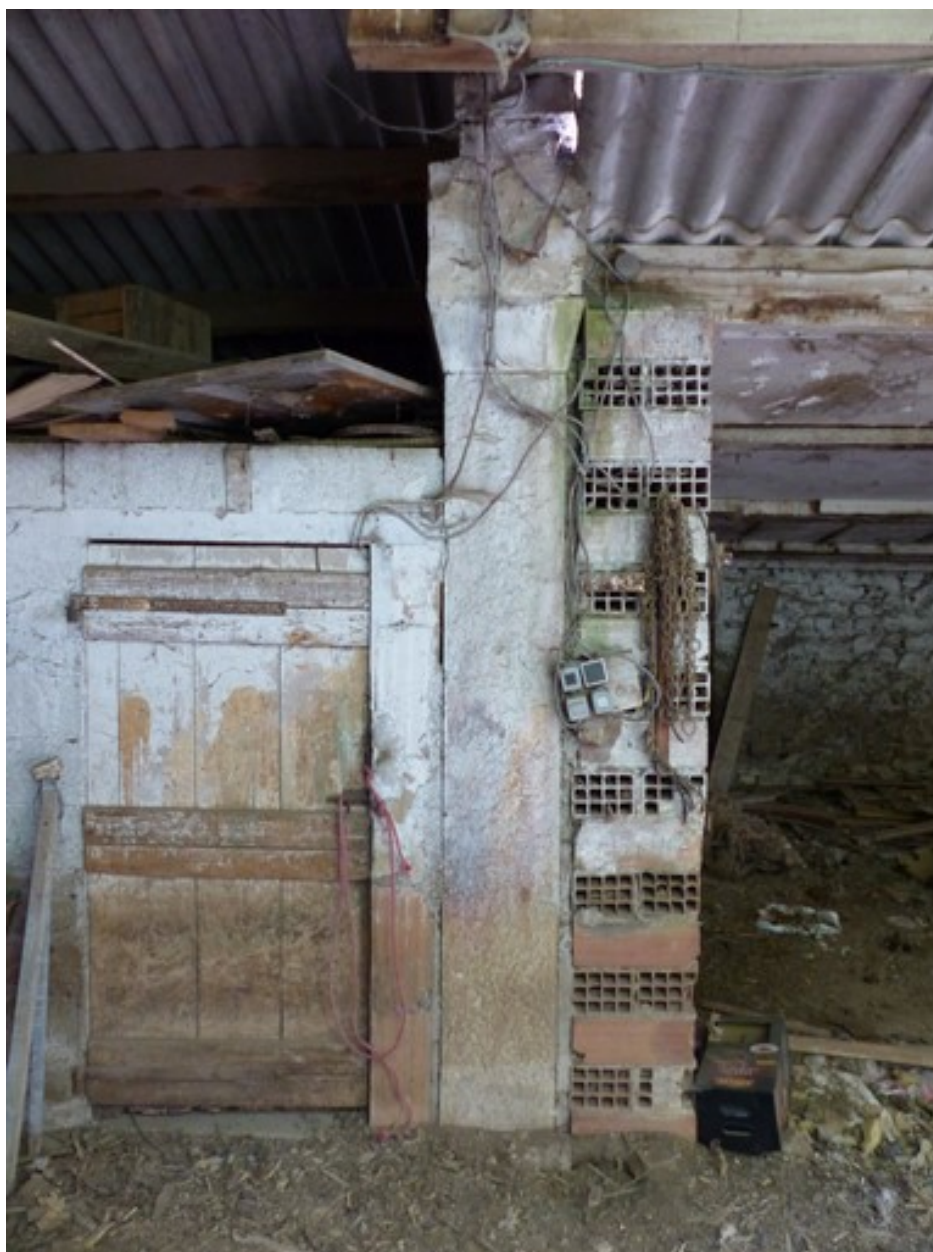
Remise sud-ouest. Pilier monolithe.
