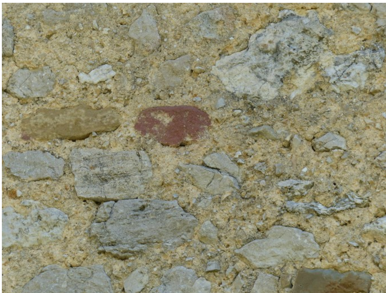
Partie ouest. Elévation ouest, détail de la maçonnerie.
