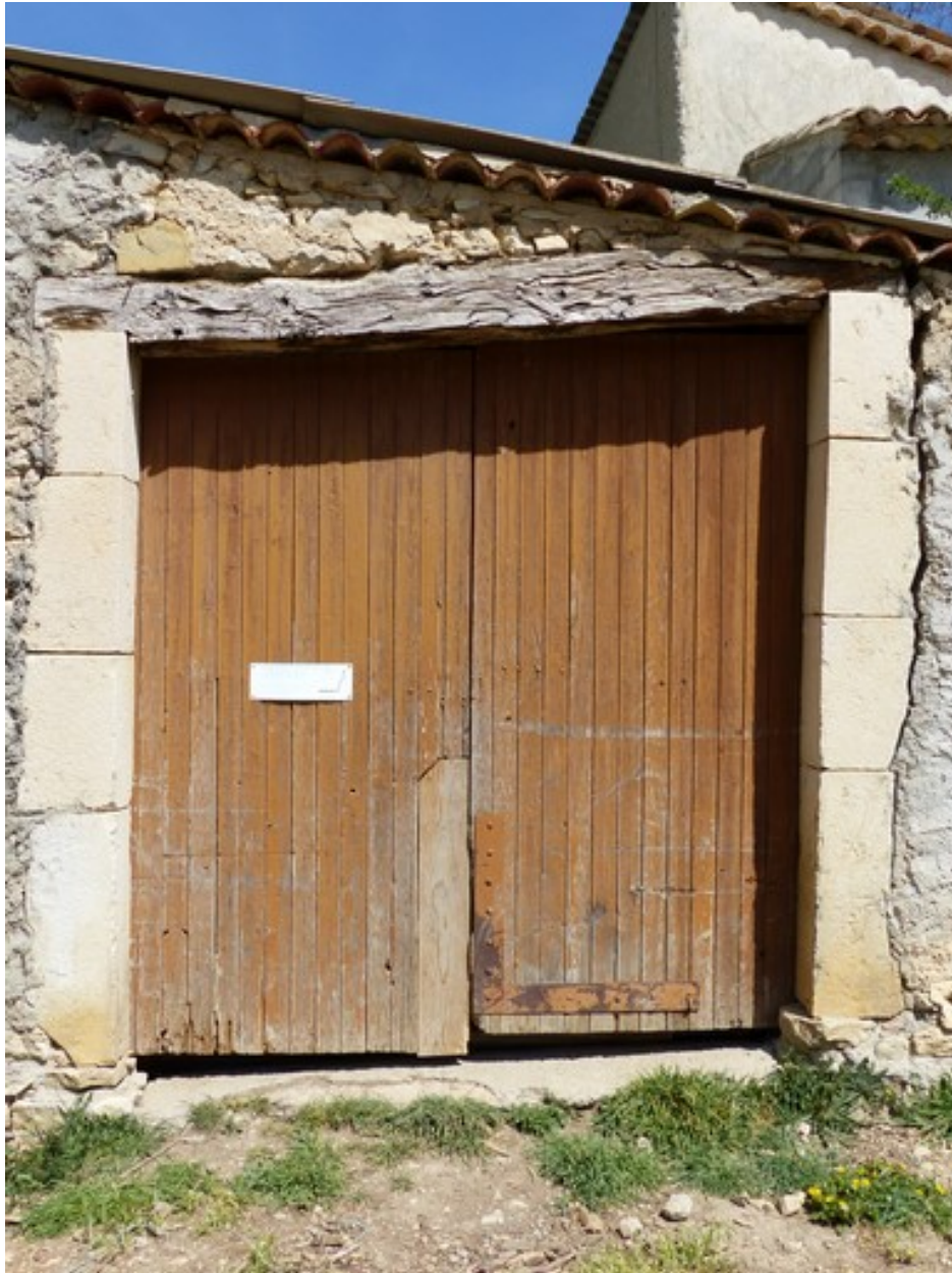
Remise sud-ouest. Elévation sud, porte.
