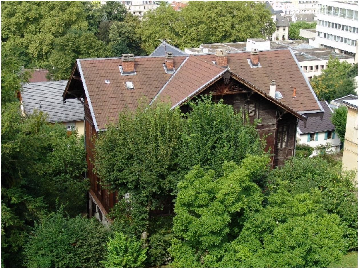
Vue de la toiture
