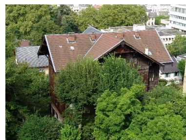
Vue de la toiture Phot. François Fouger IVR82_20087300866NUCA
