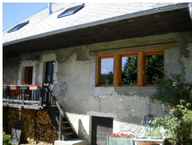
Vue de la façade sud avec la fenêtre agrandie. Phot. Clémence Serve IVR82_20117400903NUCA
