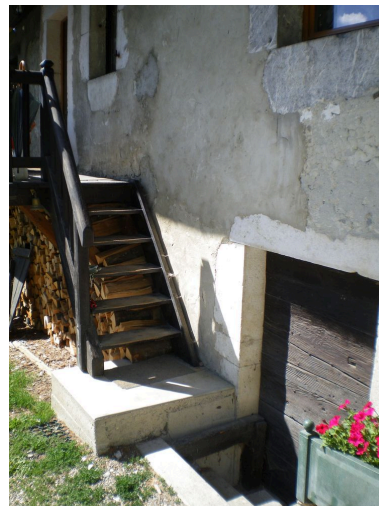
Vue de la porte de la cave. Phot. Clémence Serve IVR82_20117400876NUCA
