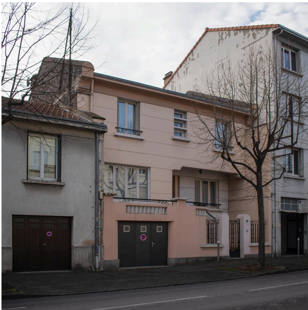
Façade sur le boulevard Jean-Jaurès
