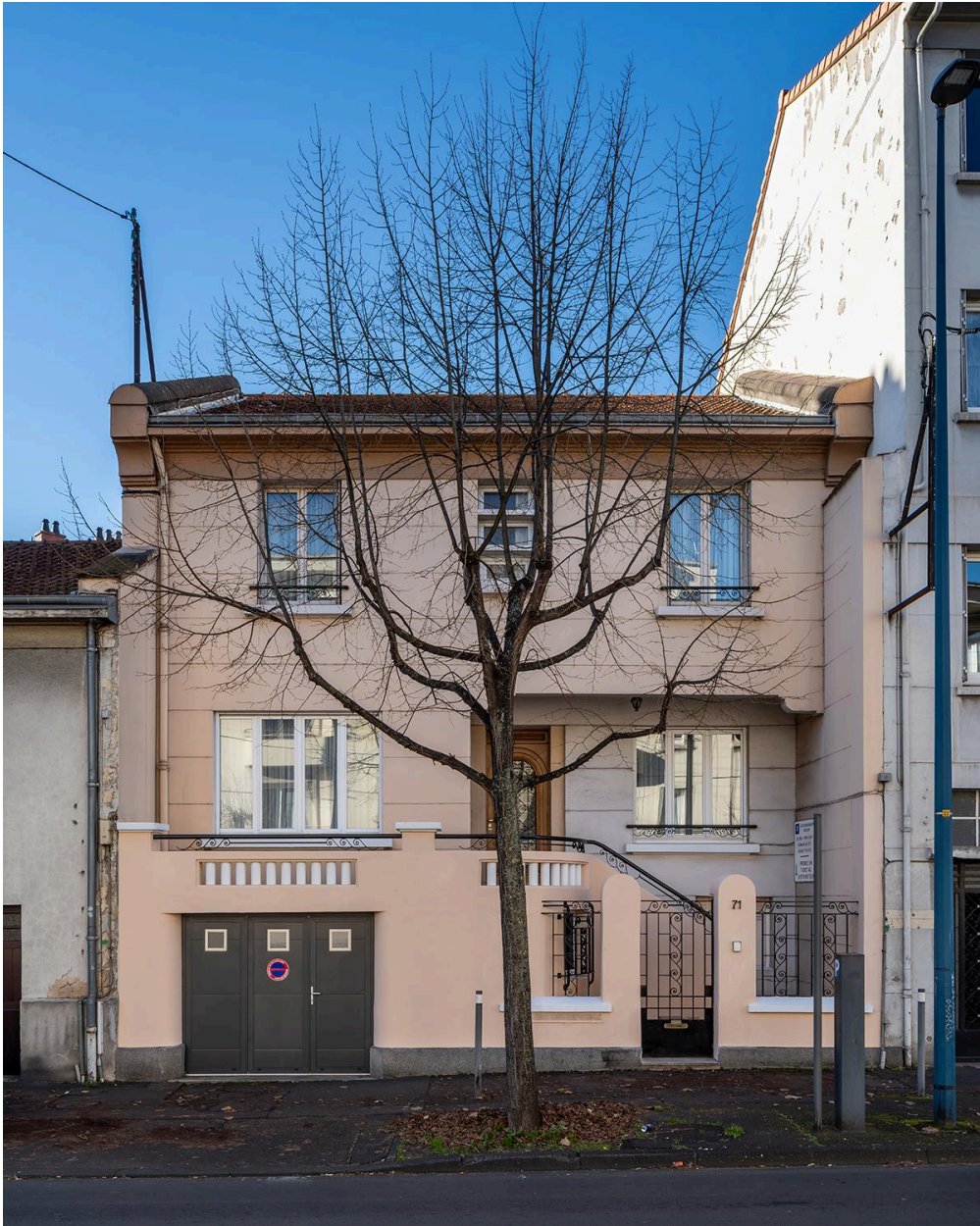
Façade sur le boulevard Jean-Jaurès
