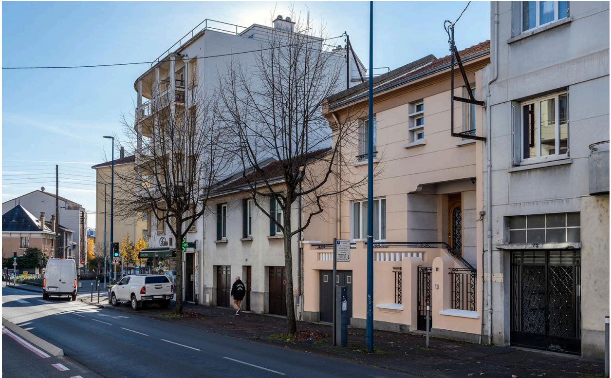
Façades sur le boulevard Jean-Jaurès
