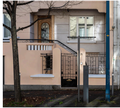
Porte d'entrée sur le boulevard Jean-Jaurès Phot. Michel Pérès IVR84_20256302602NUCA
