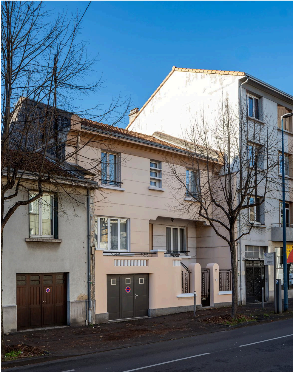
Façade sur le boulevard Jean-Jaurès
