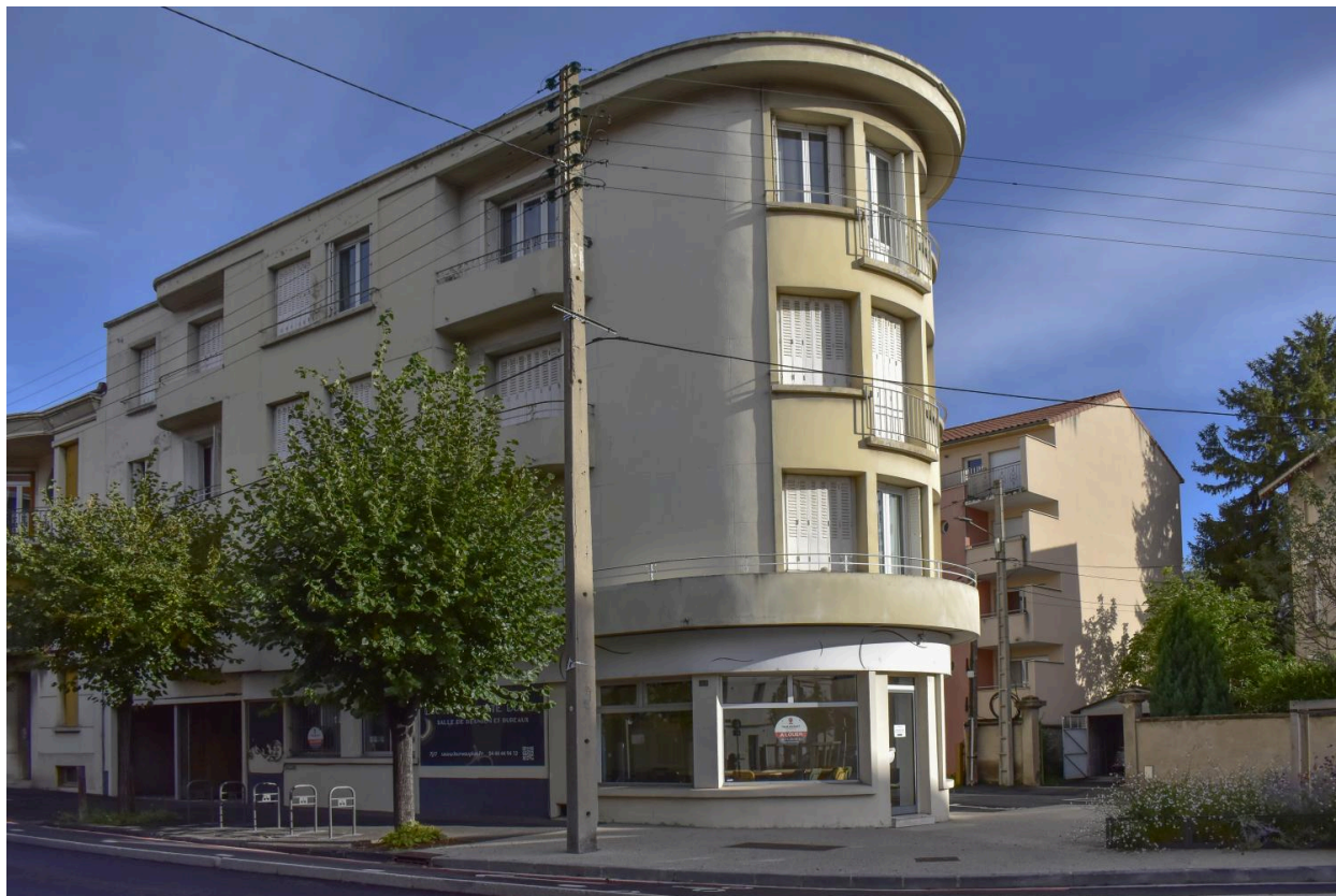
Edifice de comparaison. N°62 boulevard Jean-Jaurès, angle de la rue de Vallières
