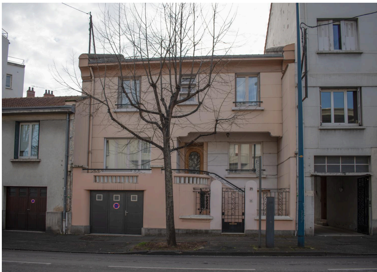
Façade sur le boulevard Jean-Jaurès
