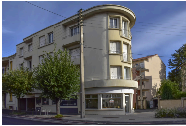
Edifice de comparaison. N°62 boulevard Jean-Jaurès, angle de la rue de Vallières Phot. Félicie Fougère IVR84_20256300429NUCA
