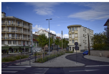
Débouché du boulevard Jean- Jaurès sur la place Littré Phot. Félicie Fougère IVR84_20256302176NUCA
