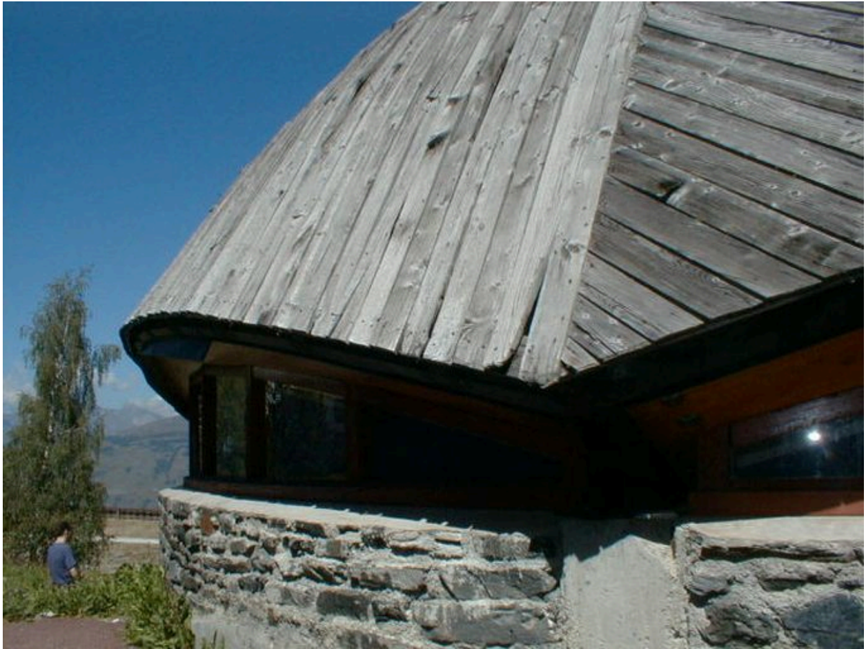
Détail de la toiture
