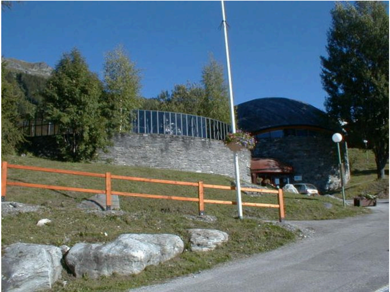
Le chemin d' accès
