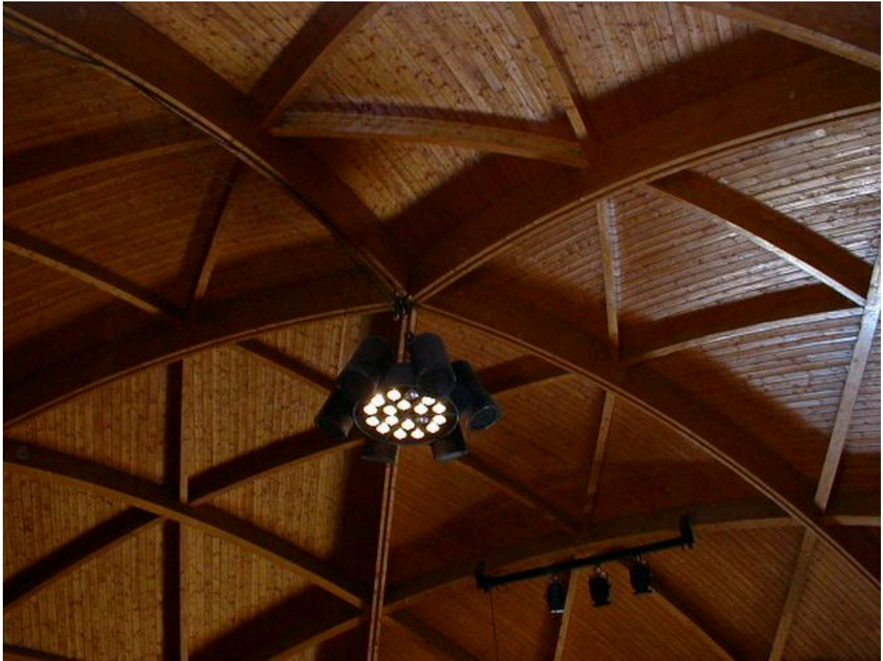
Détail de la charpente
