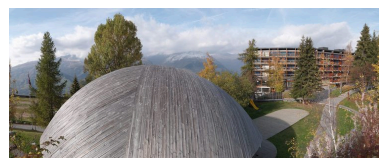
Vue générale depuis le sud Phot. Eric Dessert IVR82_20117301515NUCA
