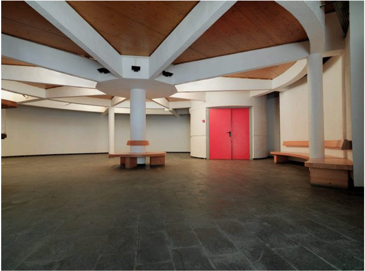
L'étage de soubassement. Le pilier central supportant la structure octogonale de poutres en béton armé soutenant le plancher de bois
