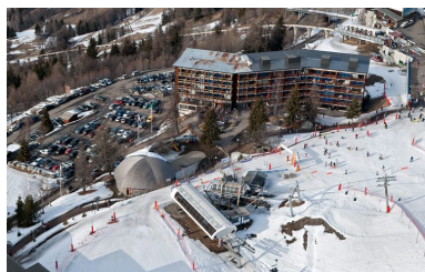
Vue aérienne depuis le sud Phot. Eric Dessert IVR82_20117302710NUCA
