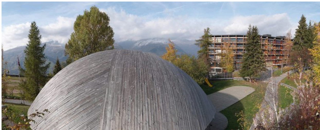
Vue générale depuis le sud
