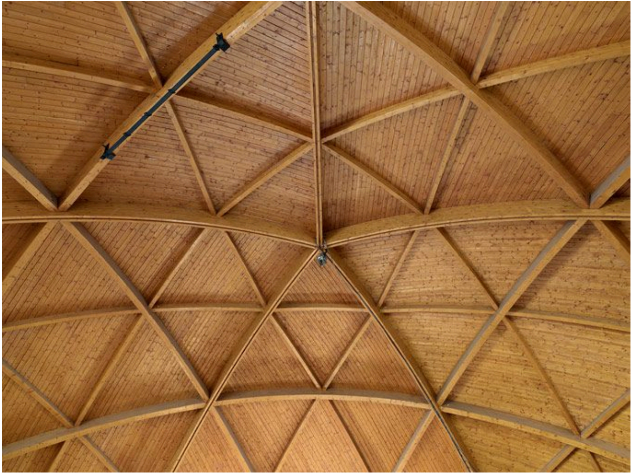
Auditorium. Détail de la charpente. Dessin à l'origine du logo des Arcs
