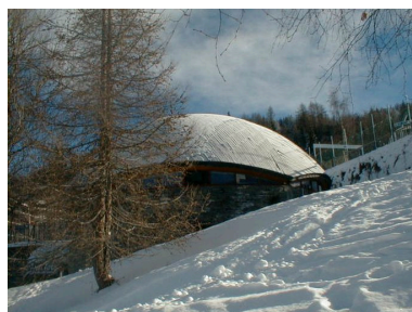
Vue d'ensemble depuis le sud-ouest Phot. C. Salomon IVR82_20057301088NUCA
