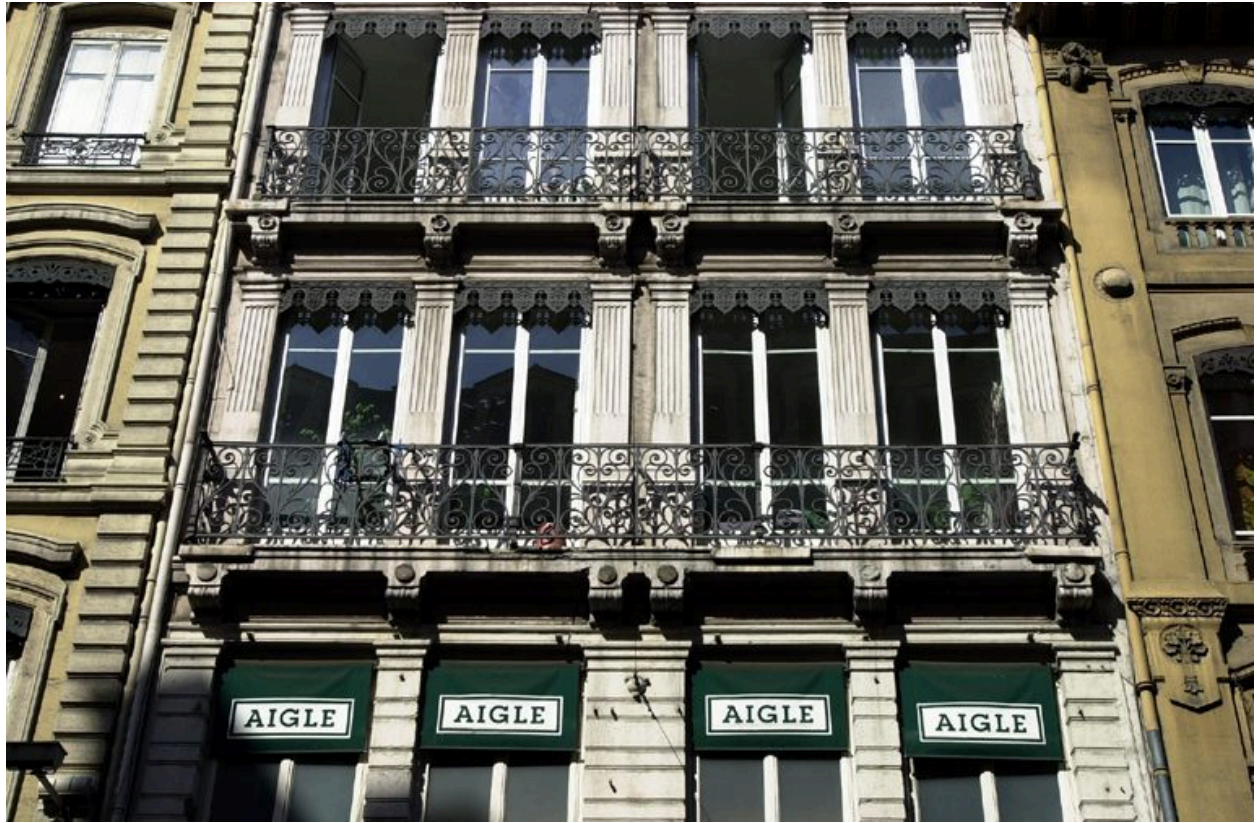
Élévation antérieure : deuxième étage carré
