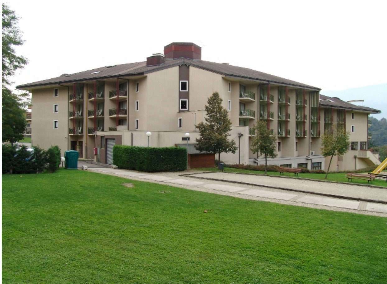
Façades nord et est
