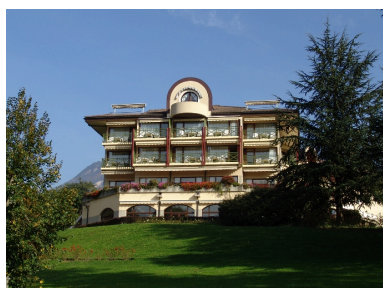
Vue prise du sud Phot. François Fouger IVR82_20067300721NUCA
