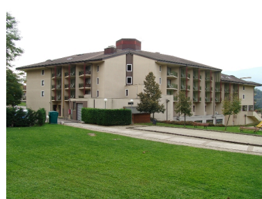
Façades nord et est Phot. François Fouger IVR82_20067300720NUCA
