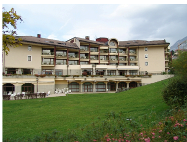
Façade ouest Phot. François Fouger IVR82_20067300783NUCA
