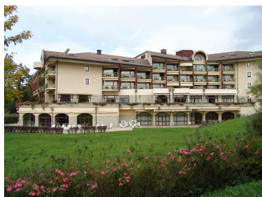
Façade ouest Phot. François Fouger IVR82_20067300782NUCA
