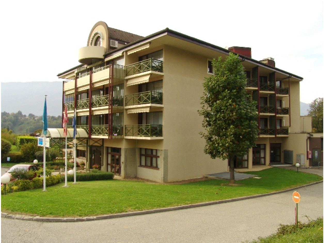
Vue prise du sud-ouest
